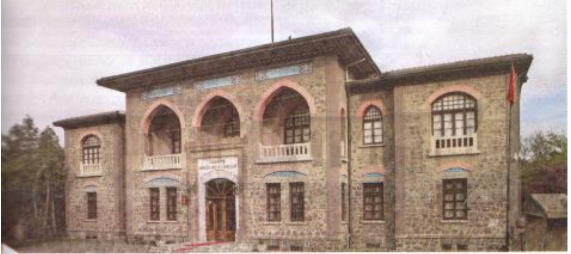
Görsel 16 : 1924-1960 Yılları Arasında Kullanılan TBMM II. Binası (Kurt, 2019, s. 67).
