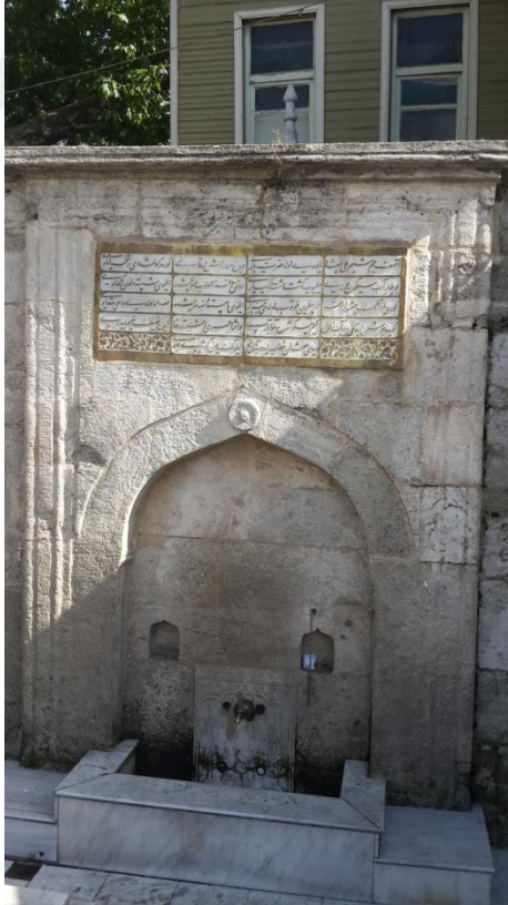
Şekil 4.2. Ali Paşa Çeşmesi (Kadıköy)
