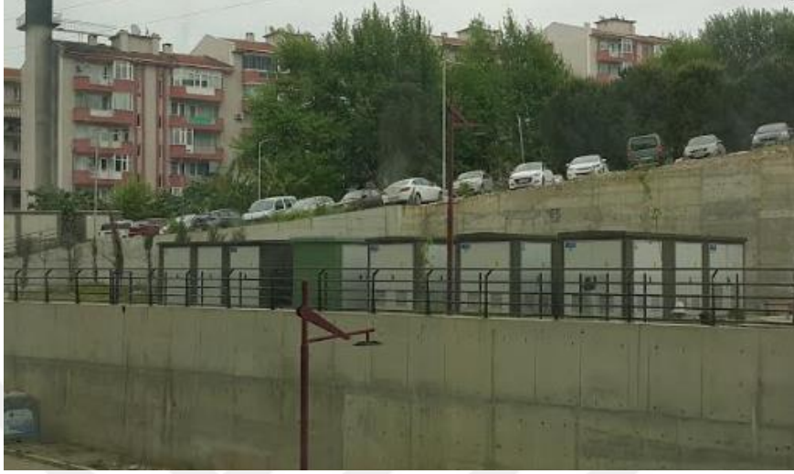
Şekil 3.4. Köşk tipi orta gerilim trafo
