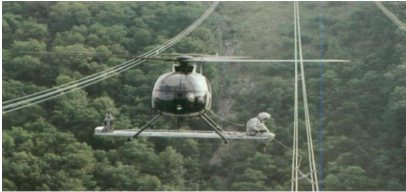
Şekil 2.3. Enerji iletim hatlarında potansiyelde çalışma yöntemi [17]
