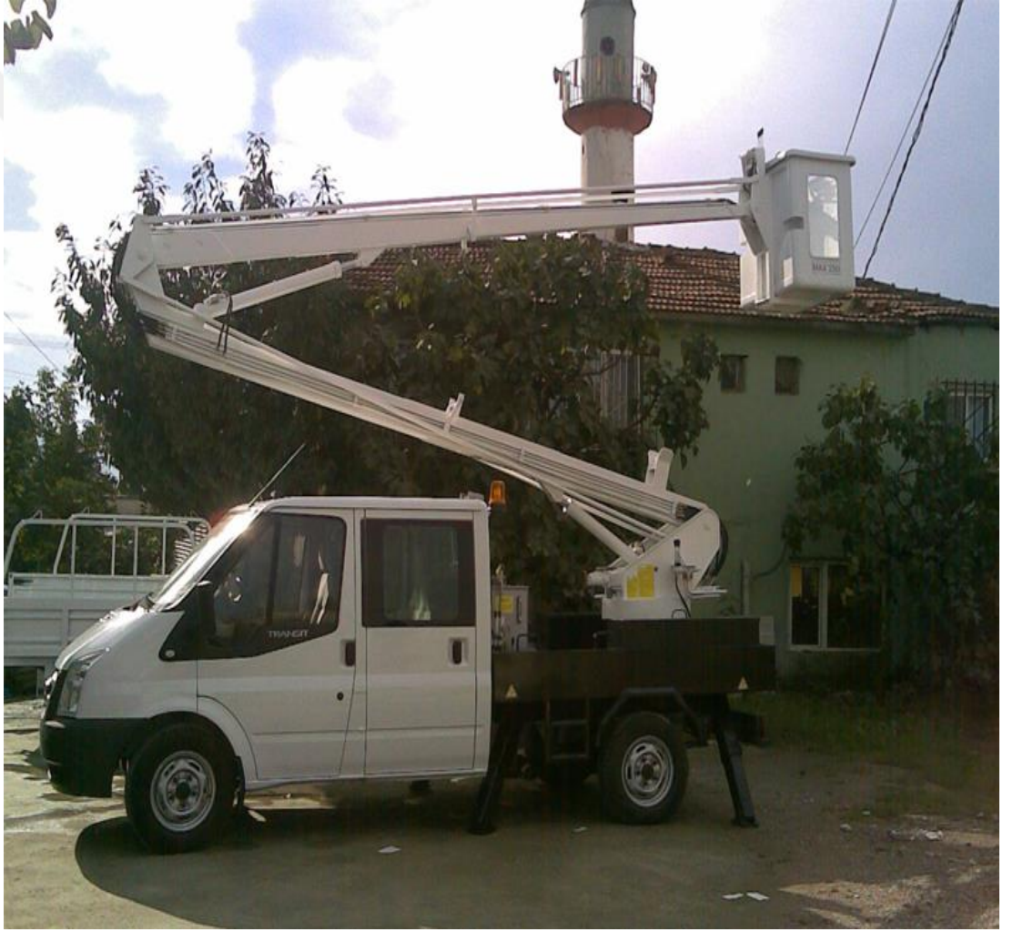
Şekil 2.2. Eklemlı teleskopik sepetli platformun elektrik işlerinde kullanılması.
