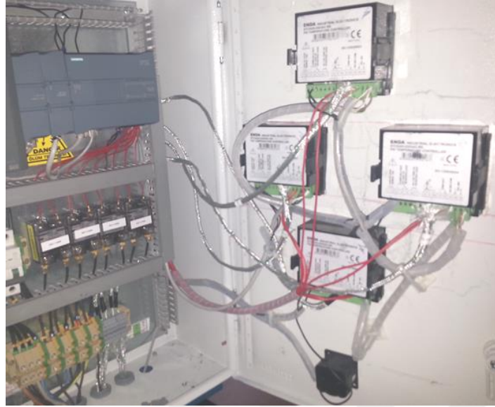
Şekil 3.11. PID sıcaklık kontrol cihazlarıyla PLC ve katı hal röleleri arasındaki bağlantıların düzenlenmesi
