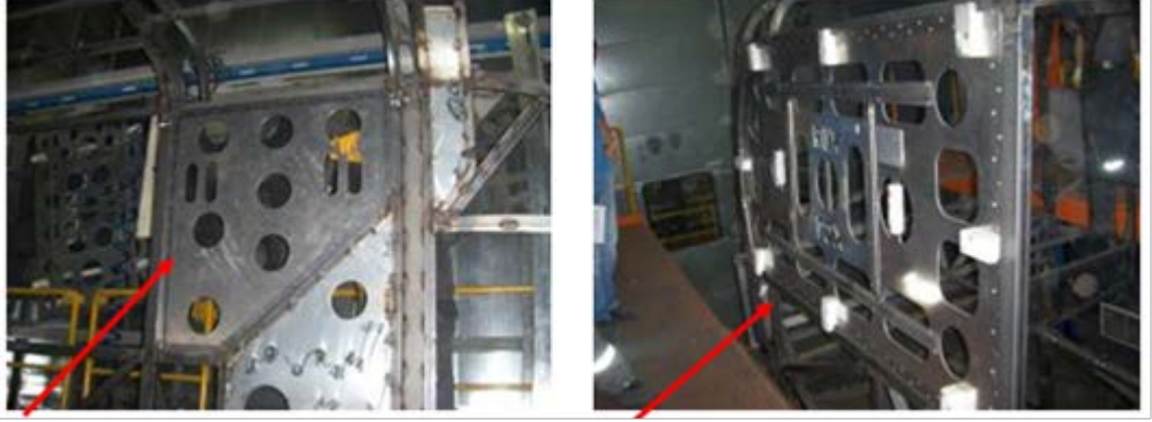
Şekil 34. Yan duvar cam yuvalarının şablon ile kontrolü
