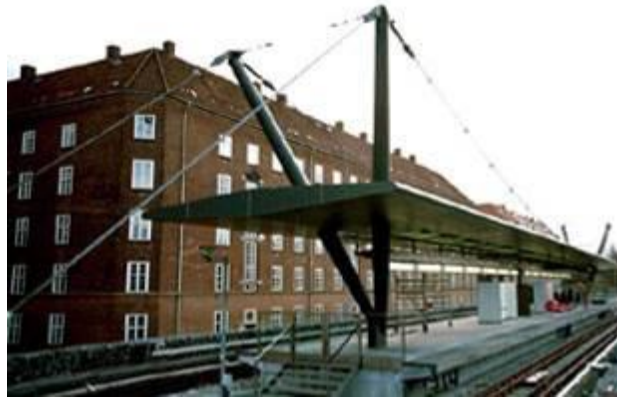
Şekil 2.8. GFRP metro istasyonu (Sarıbyık, 2008)
