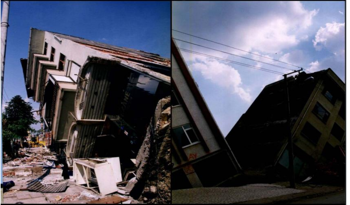
Şekil 5.7. 17 Ağustos 1999 depreminde Adapazarı'nda oluşan sıvılaşma hasarı ( www.jeofizik.org.tr ).
