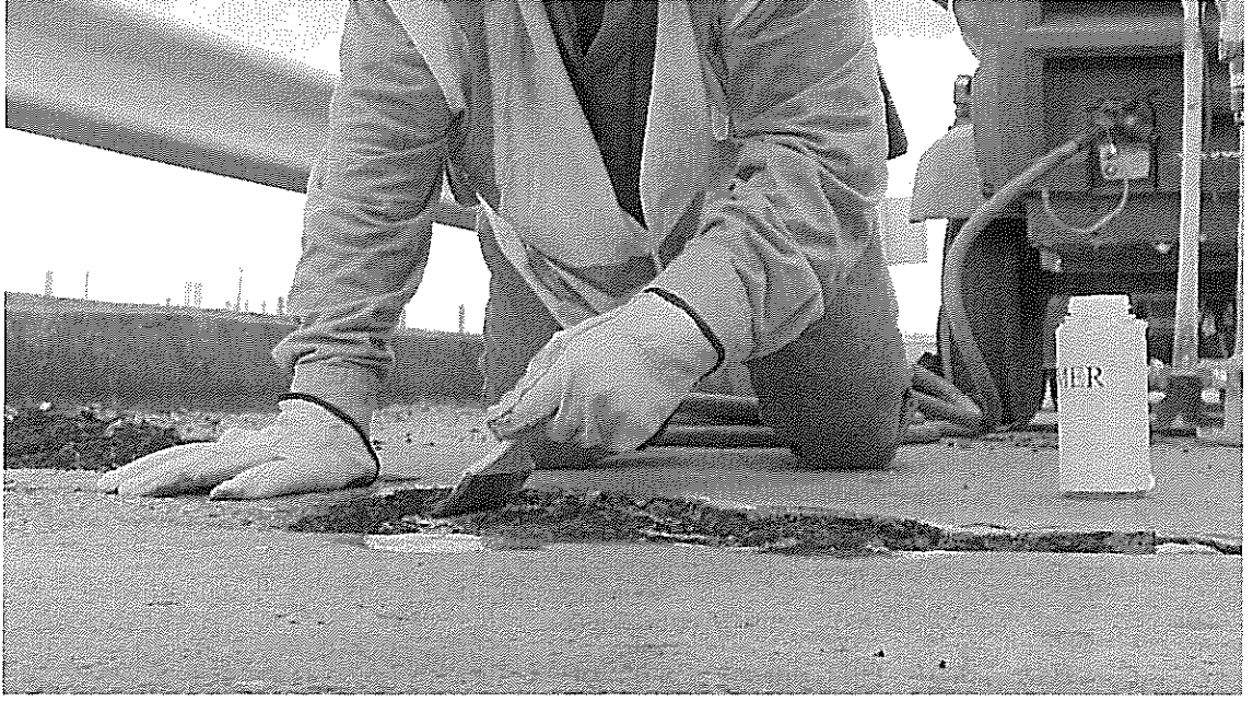
Şekil 2.5 : Polimer beton ile yapılan yol onarımı (www.youtube.com).
