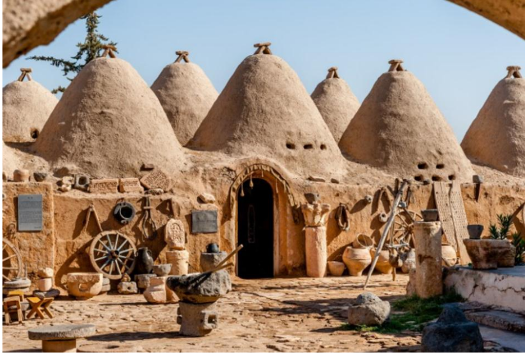
Şekil 2.3.Kerpiç kullanılarak inşa edilmiş Harran Evleri.
