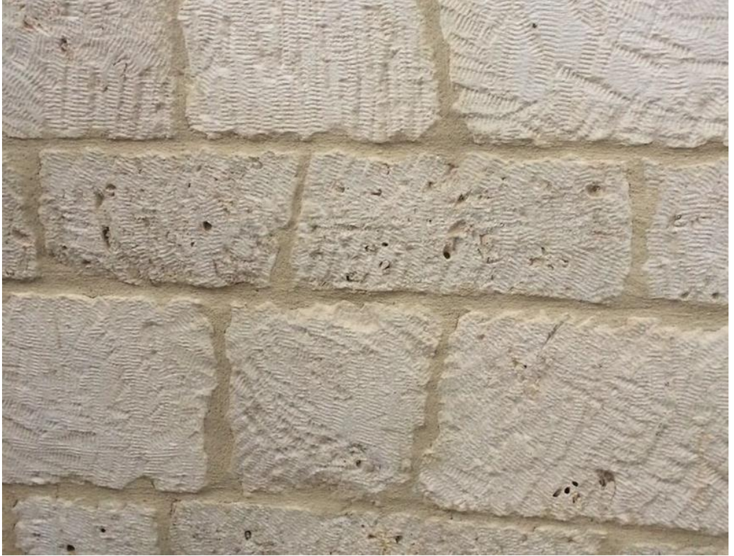
Şekil 2.11. Küfeki taşı kullanılarak inşa edilmiş duvar.
