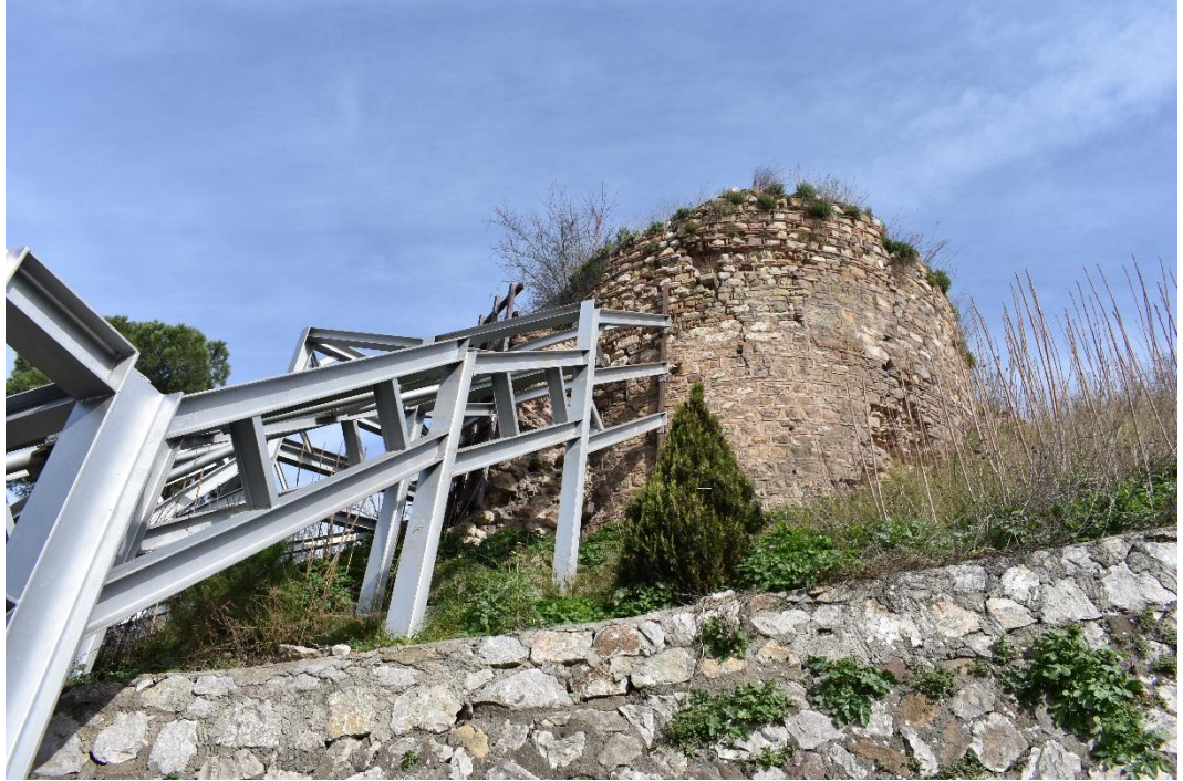
Şekil 2.7. Zemindeki kayma sonucu yapıya destek uygulaması.
