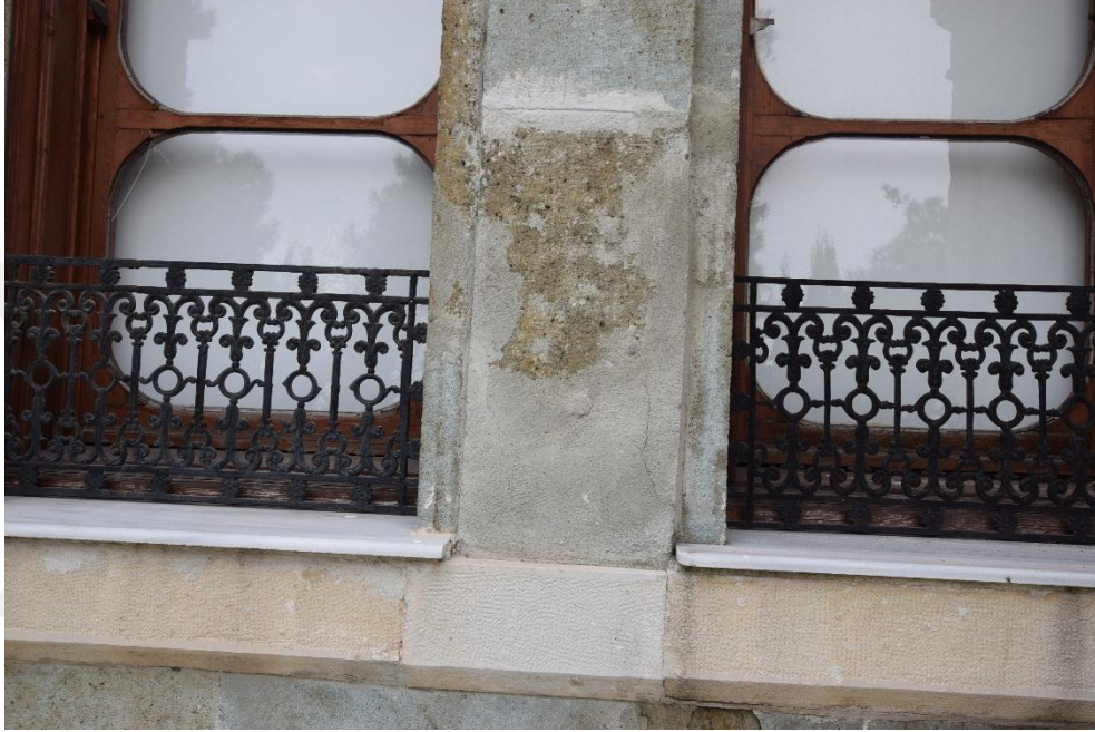
Şekil 1.1. Beden duvarlarında tamamlayıcı olarak çimento harcı kullanılmış yapı.
