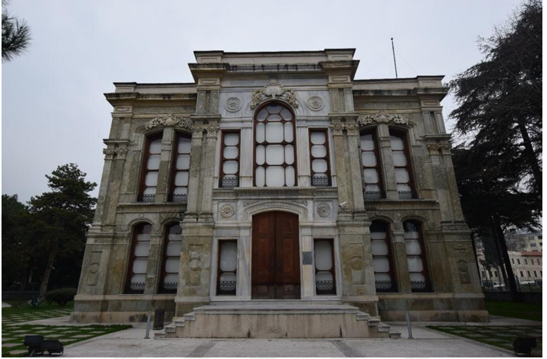
Şekil 2.4. Taş yığma yapı örneği (Av Köşkü-Kocaeli).
