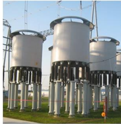
Şekil 3.15 : Tristör kontrollü reaktör ve reaktörlerin saha uygulaması gösterimi.
