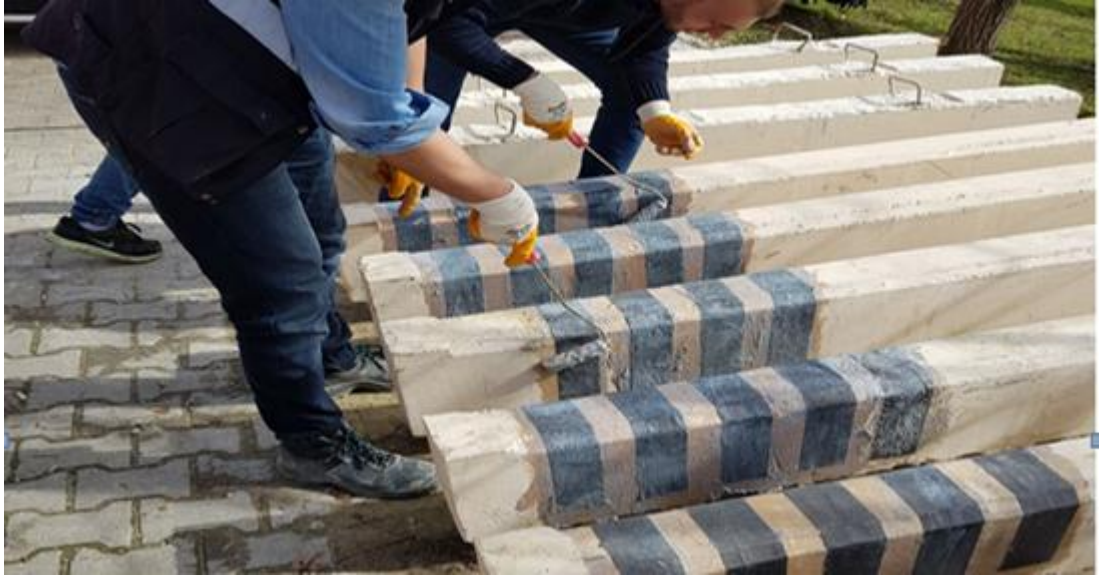
Şekil 3.16. Bazalt kumaşların kiriş yüzeyine yapıştırma işlemi.
