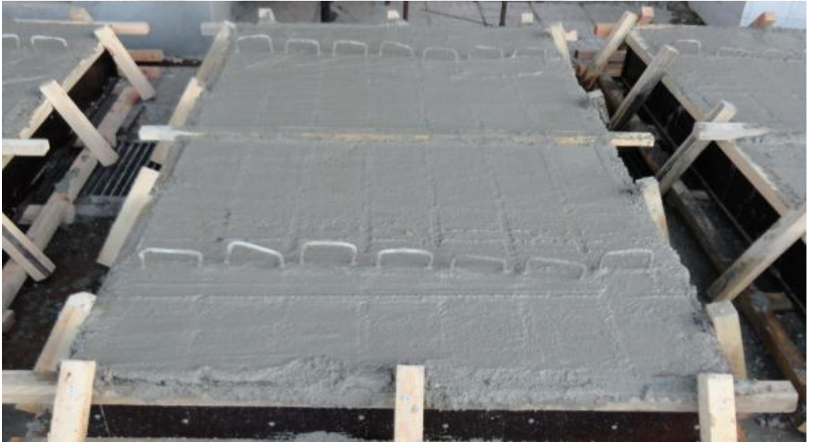
Şekil 3.13. Perdah işlemi tamamlanan kirişler.
