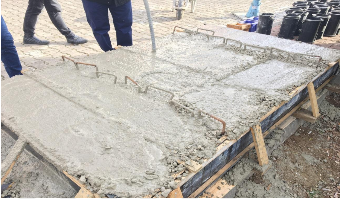
Şekil 3.12. Betonun dökümü ve yerleştirilmesi.
