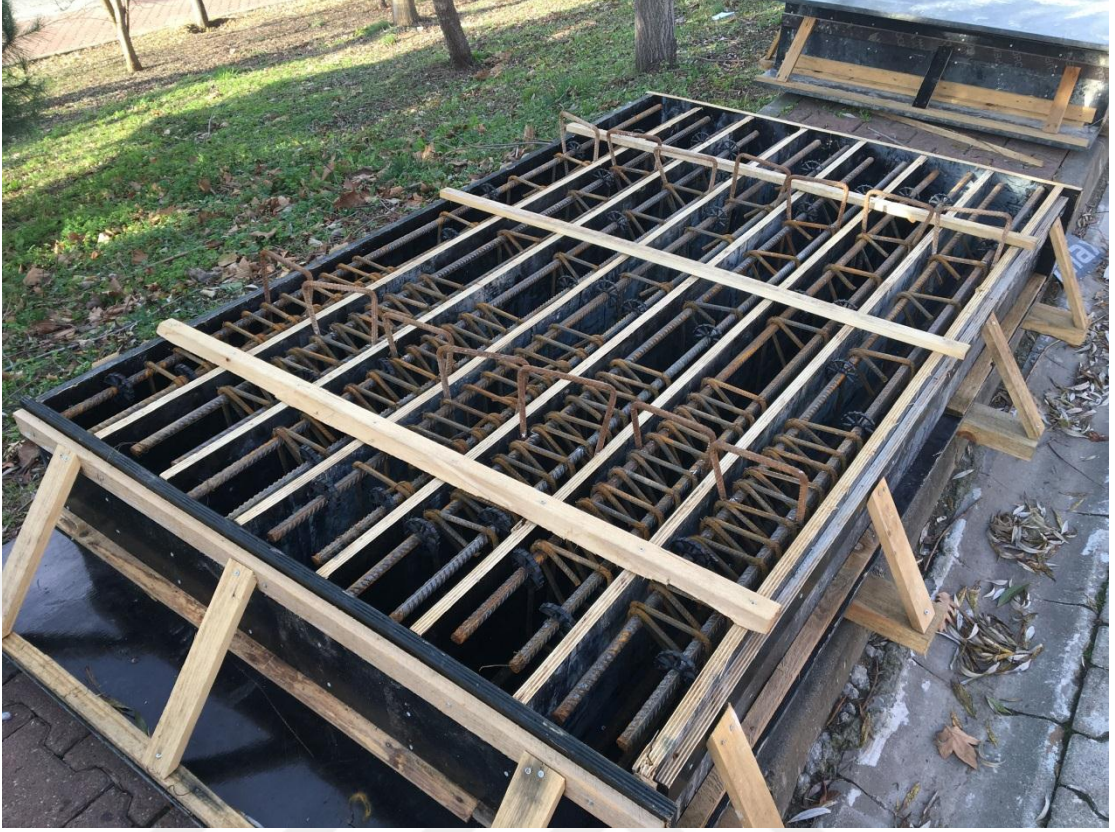
Şekil 3.11. Çelik donatısı yerleştirilen kiriş kalıbı.
