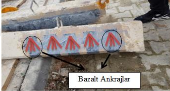
b) Ankraj uygulaması ve epoksi ile yapıştırılması.
