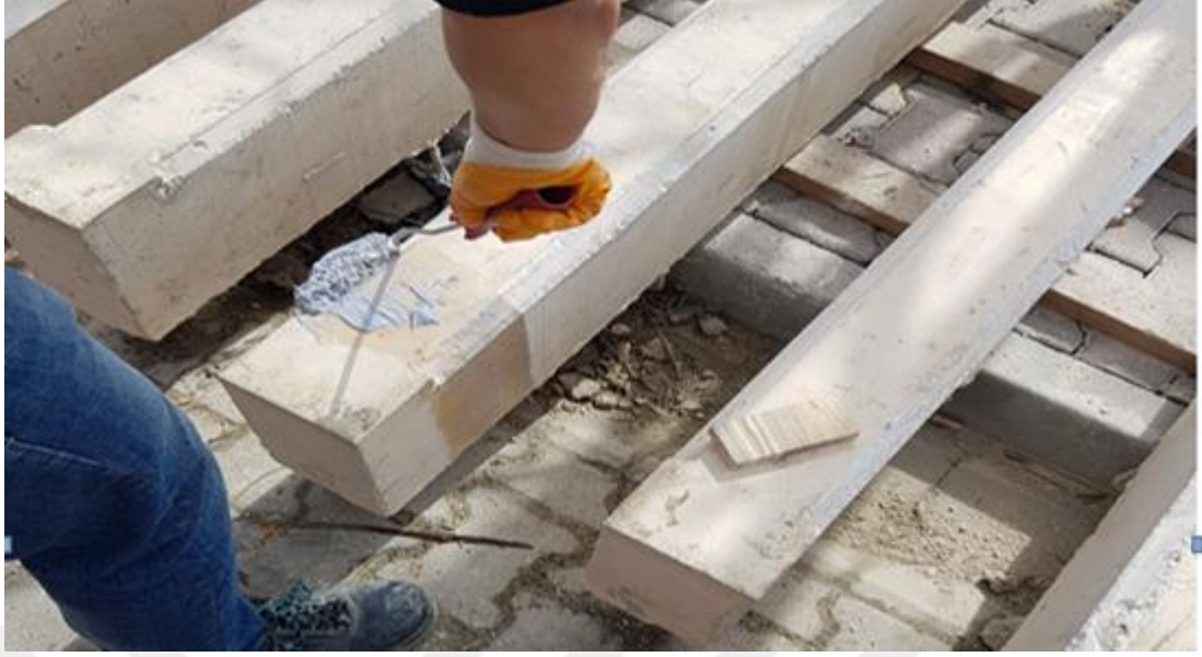
Şekil 3.15. Kiriş yüzeylerinin epoksi reçinenin sürülme işlemi.
