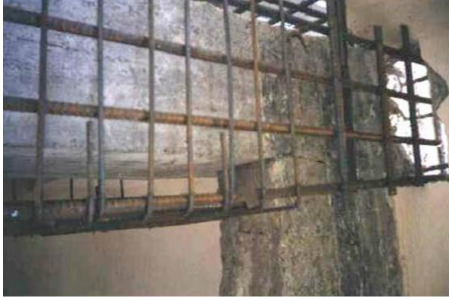
Şekil 1.6. Kiriş mantolama uygulaması.
