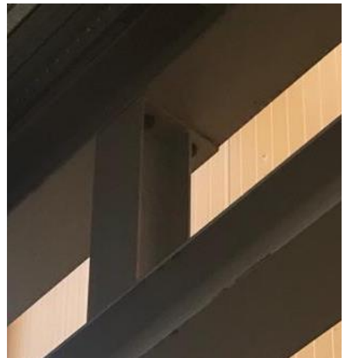
Şekil 5.8. Kiriş – Kolon Bağlantısı (Tip5)
