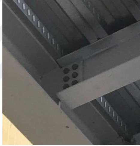
Şekil 5.7. Kiriş – Kiriş bağlantısı (Tip4)
