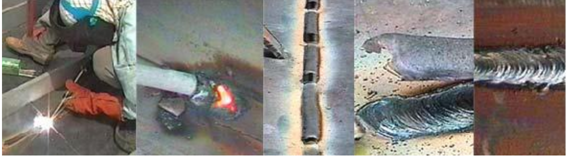
Şekil 3.9. Elektrot kaynağı uygulaması (Tama, 2016)
