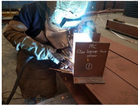
a. Kaynak işleminin yapılması
