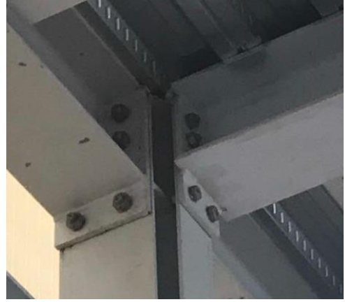
Şekil 5.6. Kolon – Kiriş bağlantısı (Tip3)
