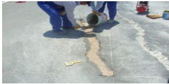
Şekil 3.2 Polimer harcı ile yollardaki çatlakların onarılması
