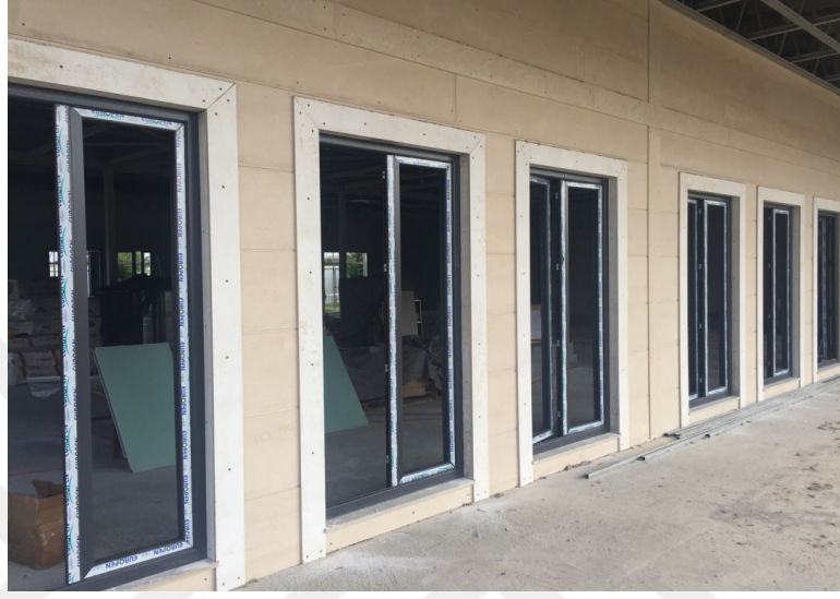
Şekil 2.2. Fibercement Levhaların Dış Cephe Uygulması
