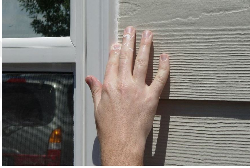
Şekil 2.5. Fibercement Levhaların Bakımı Kolay Olması
