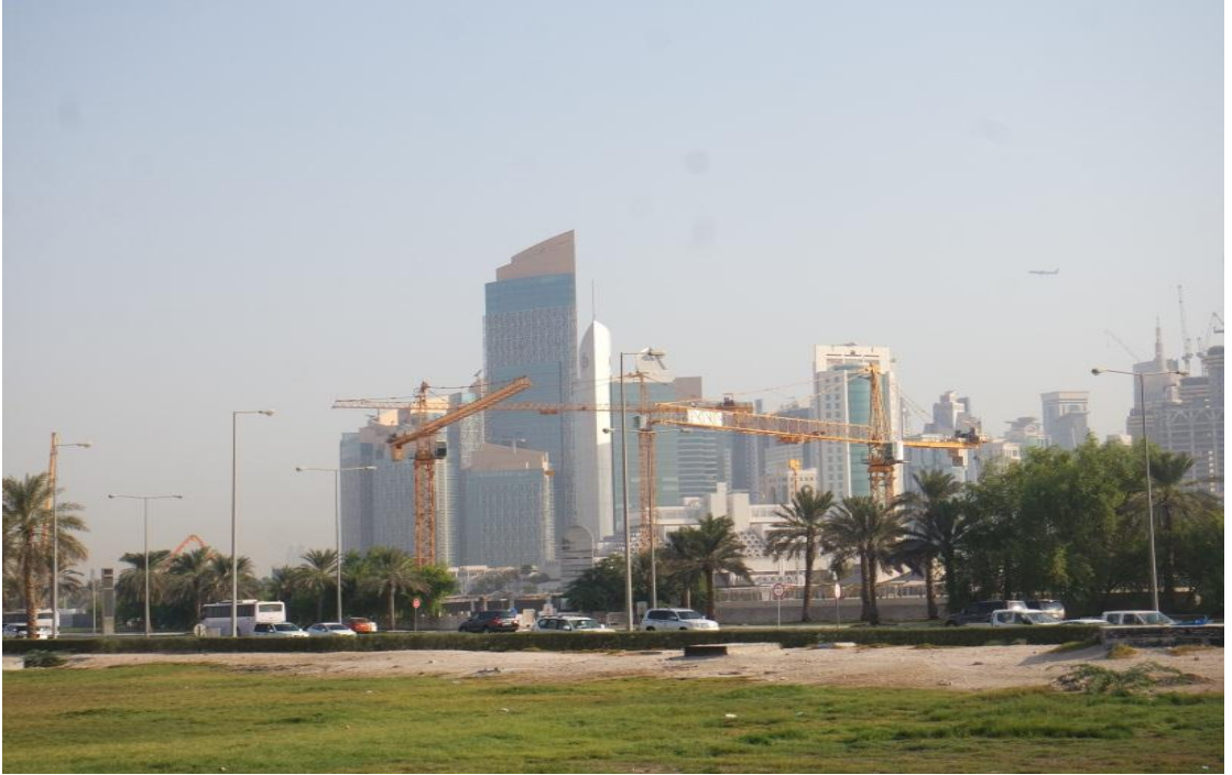
Foto 33. West Bay'da Gökdelen Yapım Çalışmaları
