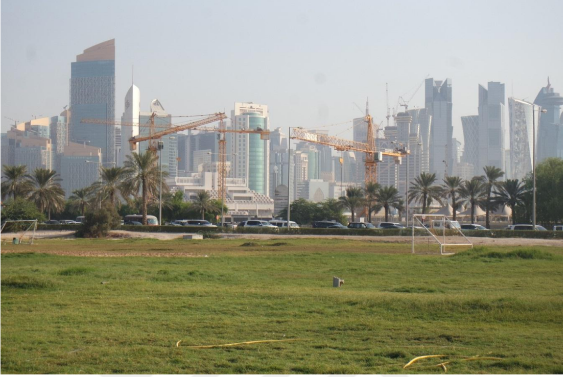
Foto 28. West Bay’da Gökdelenlerin Yapımı
