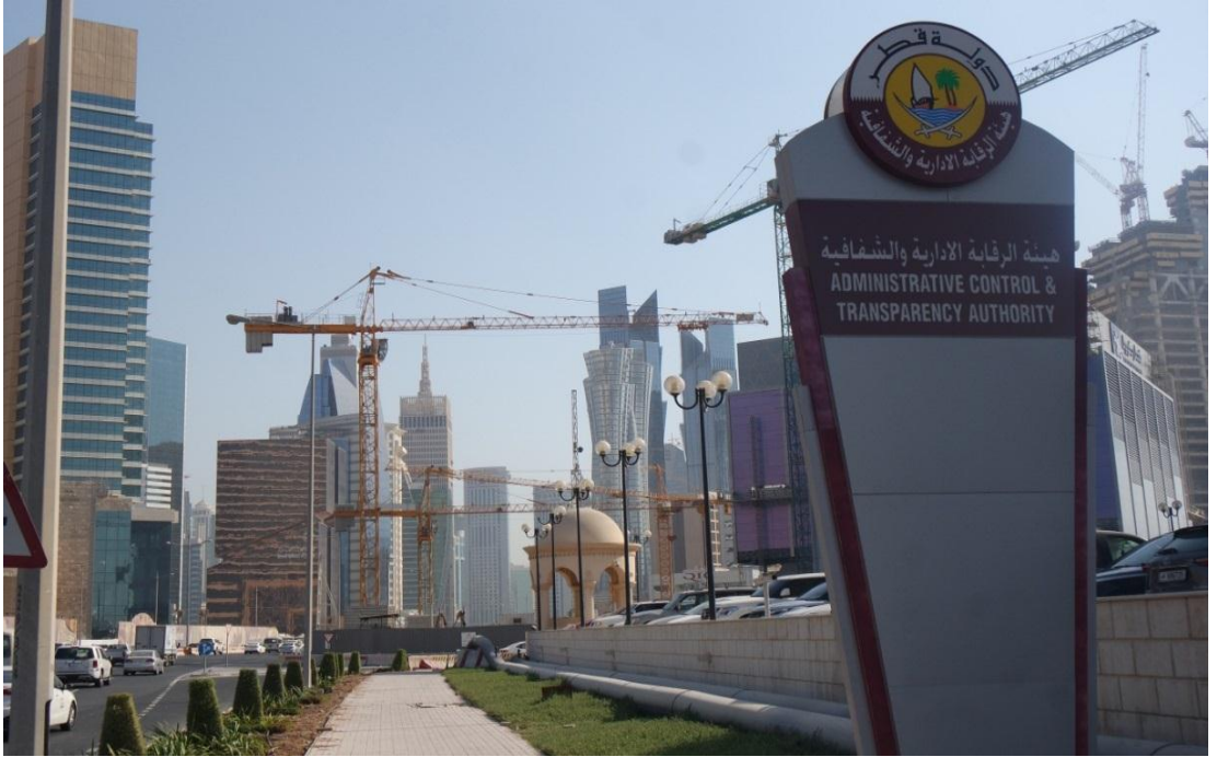
Foto 27. West Bay'da Gökdelenlerin Yapımı
