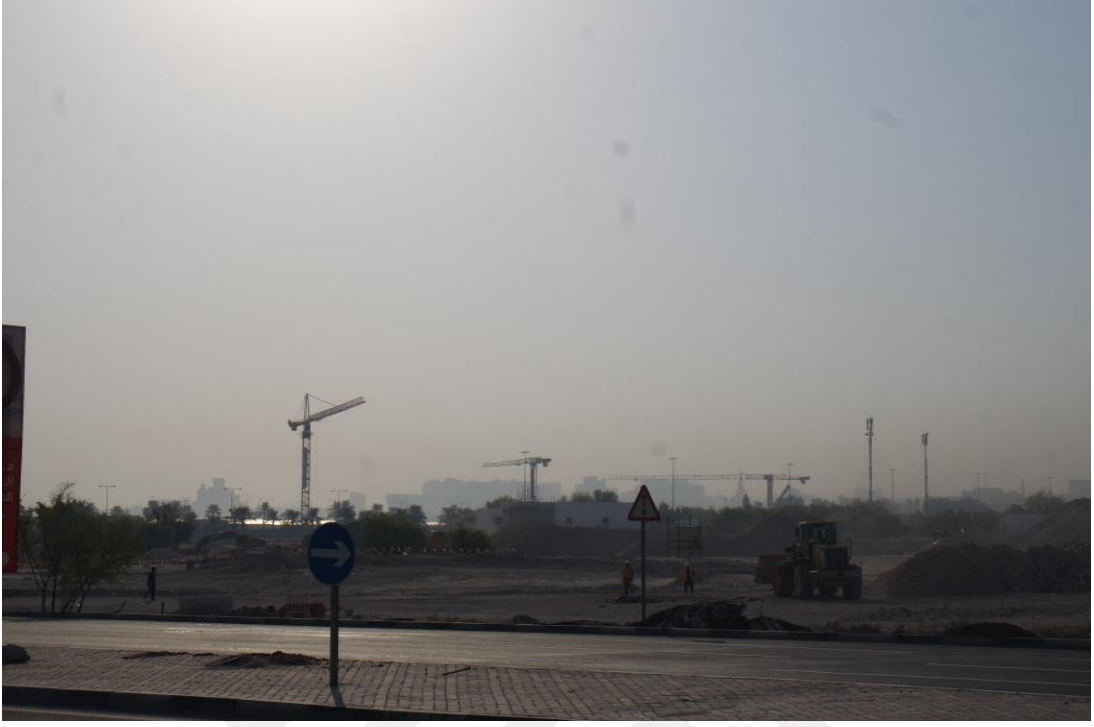
Foto 32. West Bay'da Gökdelen Yapım Çalışmaları
