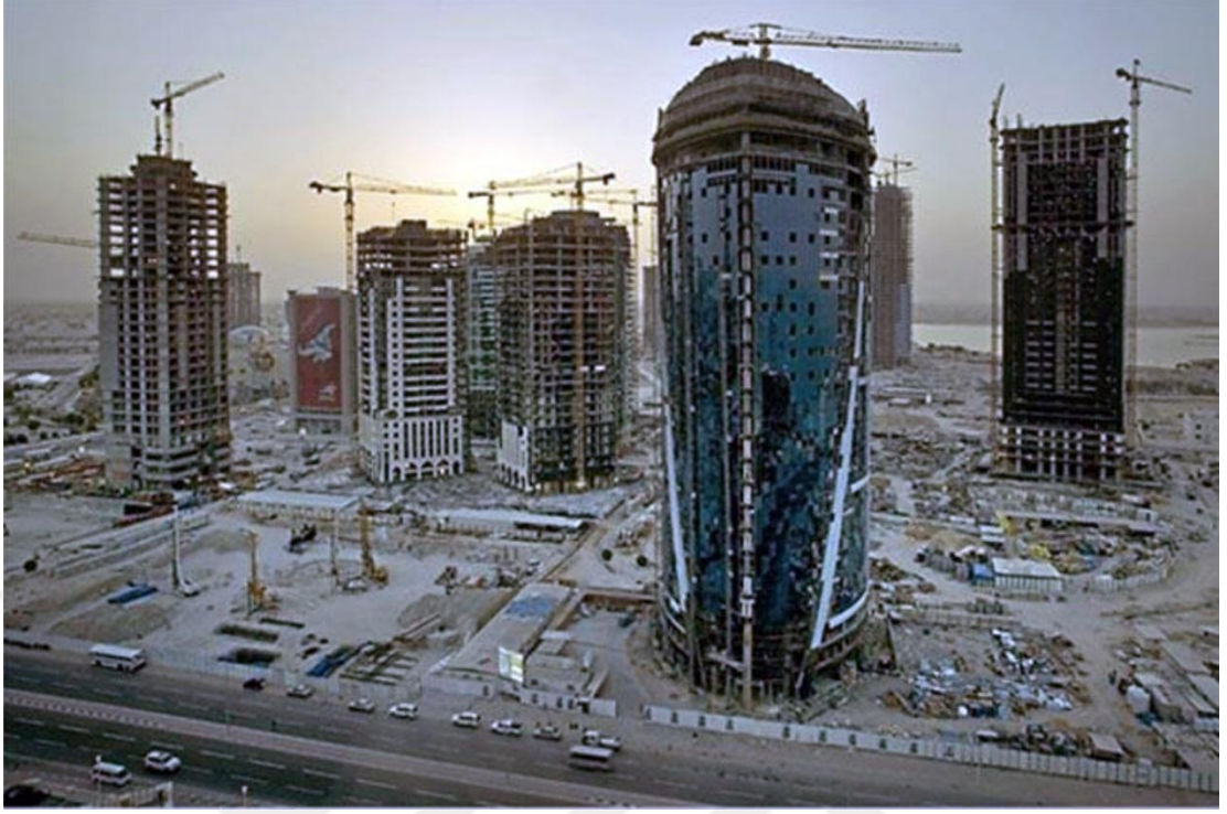
Foto 26. West Bay'da Gökdelenlerin Yapımı
