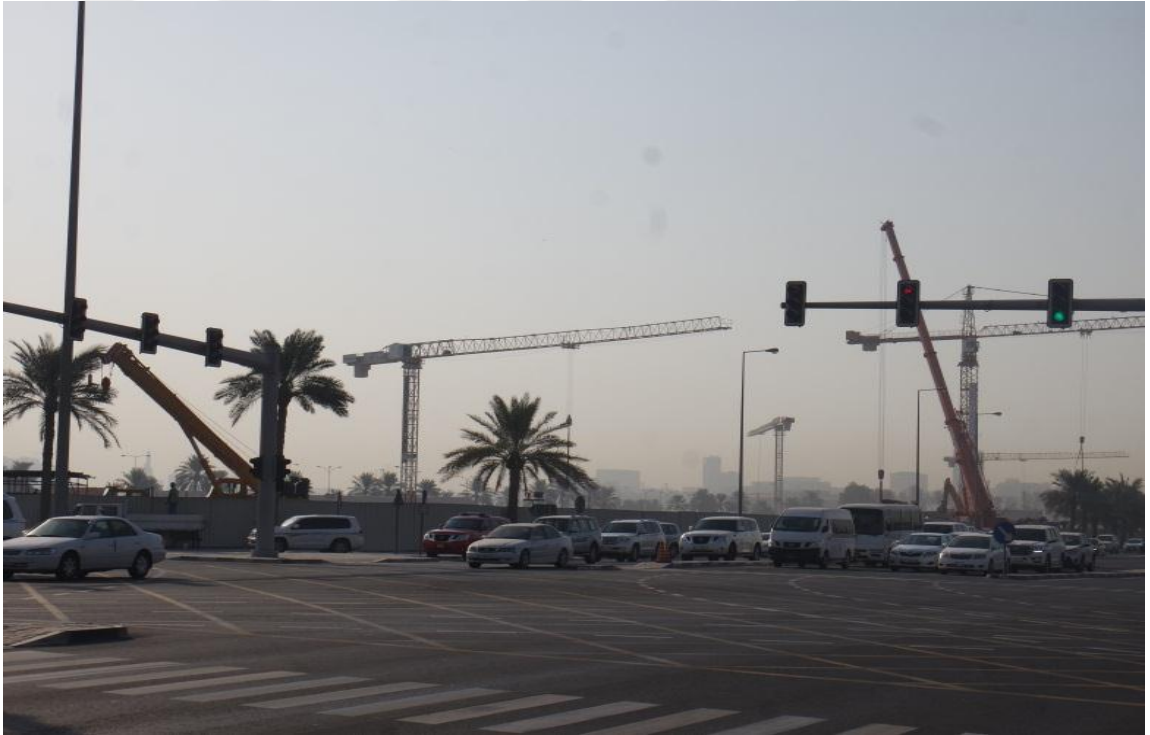
Foto 34. West Bay'da Binaların Yapımı
