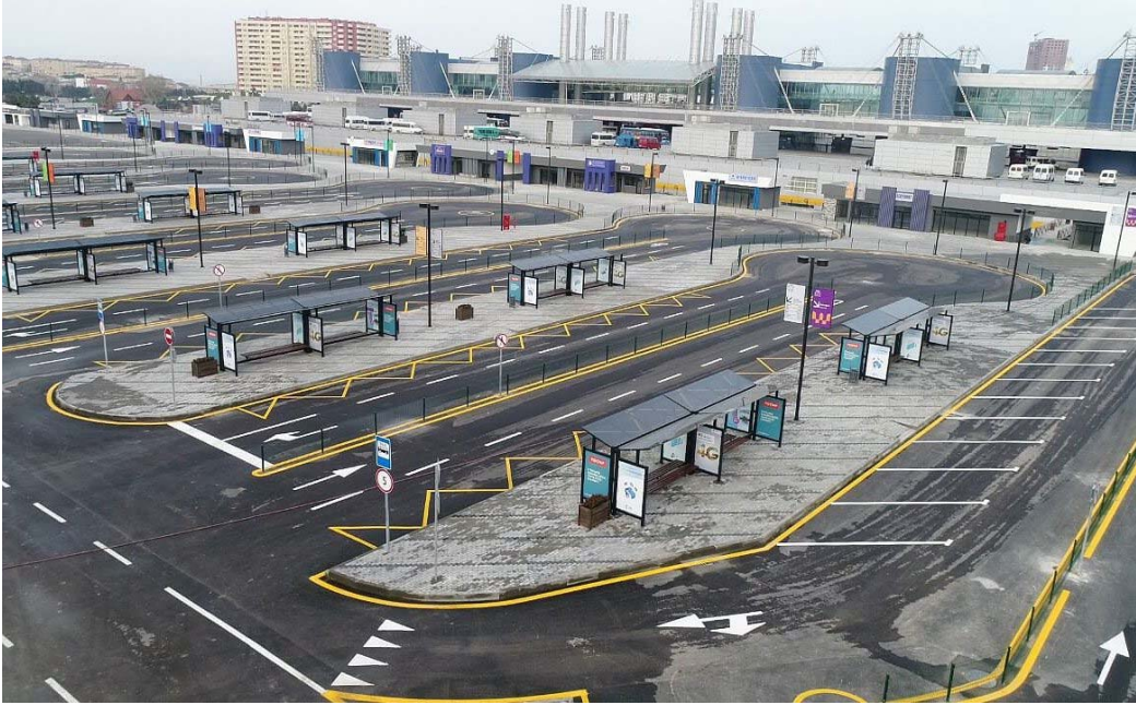
Fotoğraf 14: Bakü otobüs terminali (Bakı Beynəlxalq Avtovağzalı)
