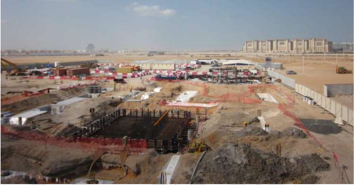
Foto 80. Masdar City İnşaatı Görseli 2012 178
