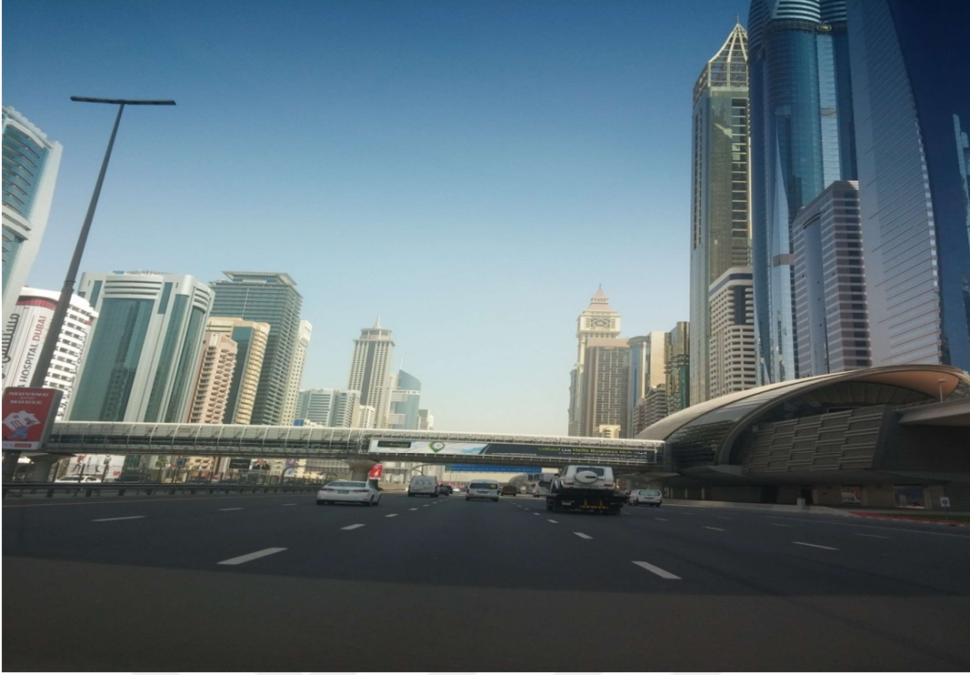
Foto 56. Dubai Finans Merkezi Yolu Üzeri 125
