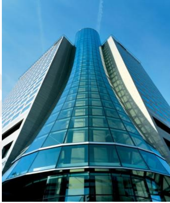
Görsel 2.16. Yapısal sır giydirme cephesi, Westin Hotel, Polonya (Shücco Giydirme Cephe Kataloğu, 2011)
