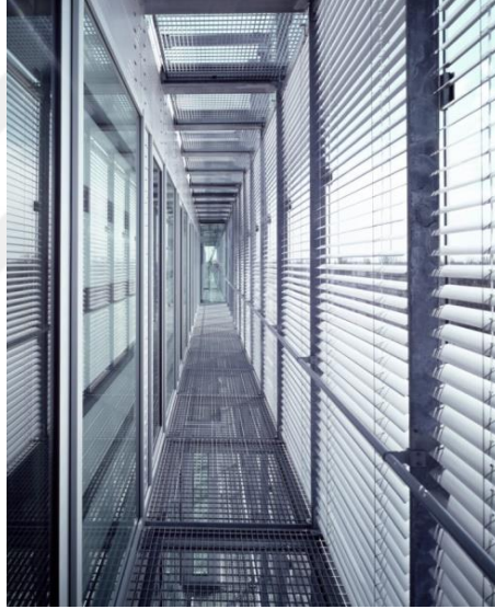
Görsel 3.8. LOT Polish Airlines binasının güney cephesinde oluşturulan çift cidarlı giydirme cephe sistemine ait koridor [56]
