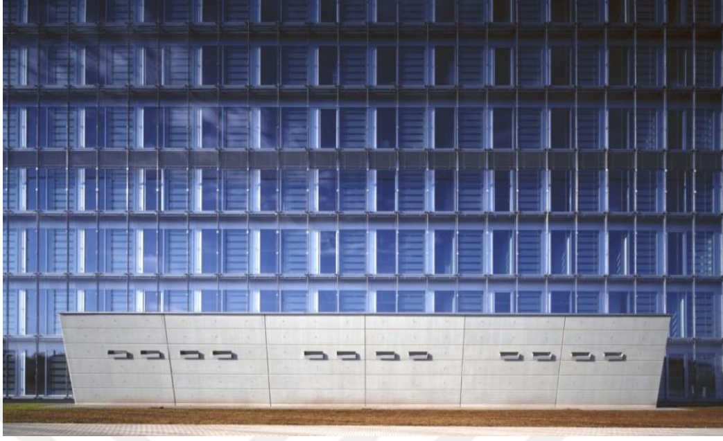
Görsel 3.10. LOT Polish Airlines binasından bir cephe detayı [54]
