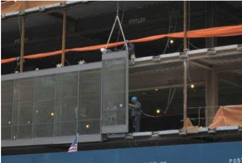
Görsel 2.19. Panel giydirme cephe sisteminin binanın dış cephesinden montajı (Metal Yapı, 2012)
