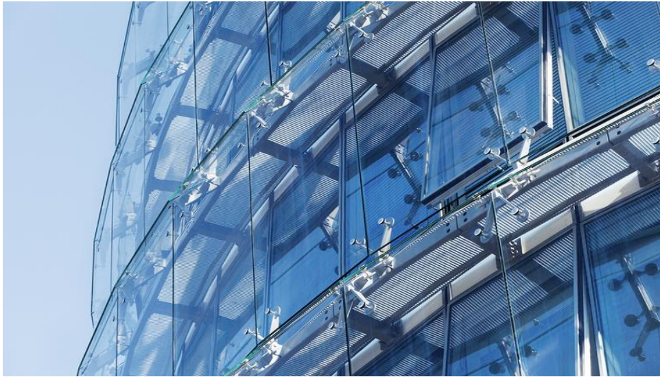
Görsel 3.15. Pomeranian bilim ve teknoloji parkı ofis binasının cephesinde yer alan hareketli güneş kırıcılar [59]
