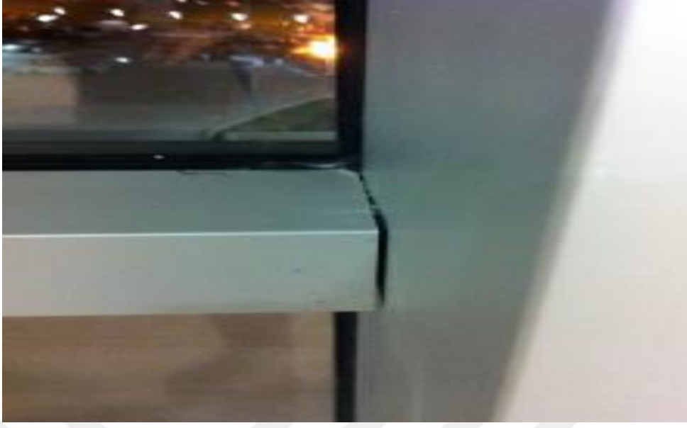
Görsel 2.35. Alüminyum profillerin yatay ve dikey bağlantısında meydana gelen ayrılma (Yazarın Bireysel Arşivi, 2012)
