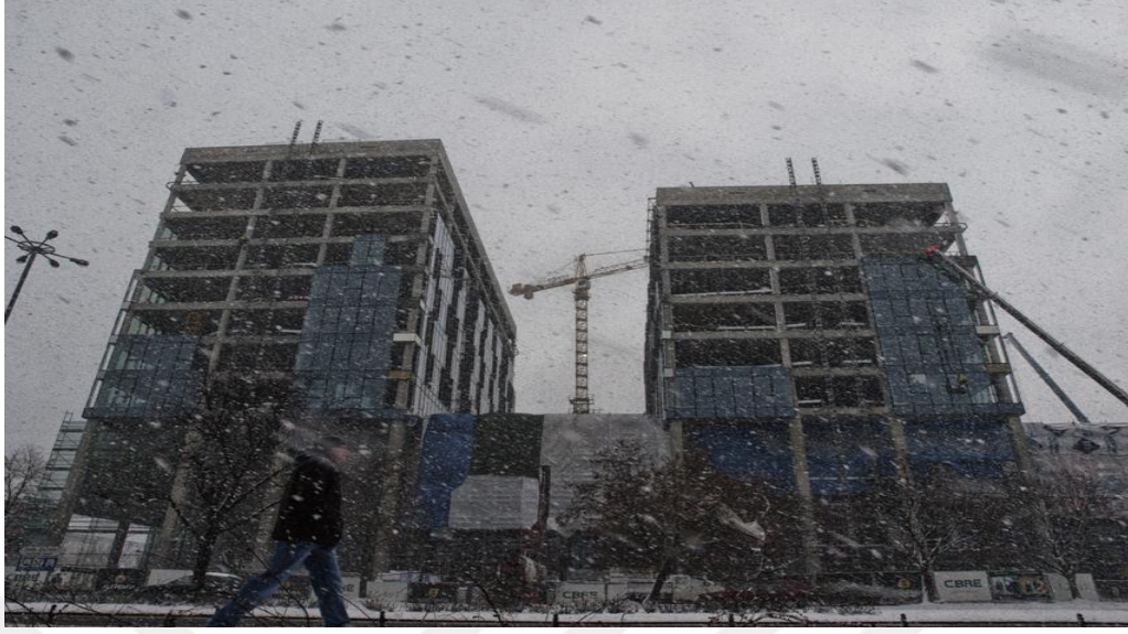
Görsel 3.3. Alchemia III binasının yapım aşamasından bir görünüş [52]
