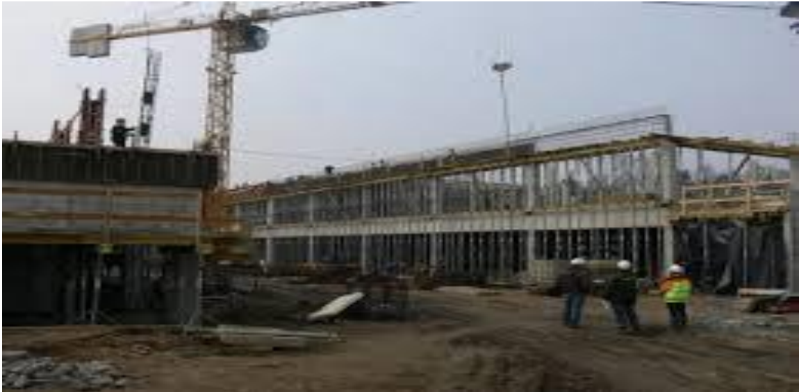
Görsel 3.1. Pulawski Bilim ve Teknoloji Parkı binası inşaat aşaması [48]
