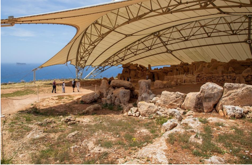
Görsel 4.7. Mnajdra Tapınağı koruyucu çatı uygulaması ( http-23 )
