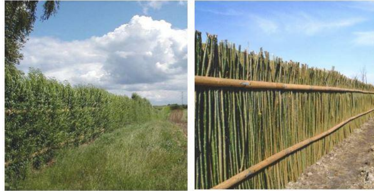
Şekil 4.18. Dal örgü yüzey kaplamalı yaşayan bio-bariyer (Bendtsen, 2009)
