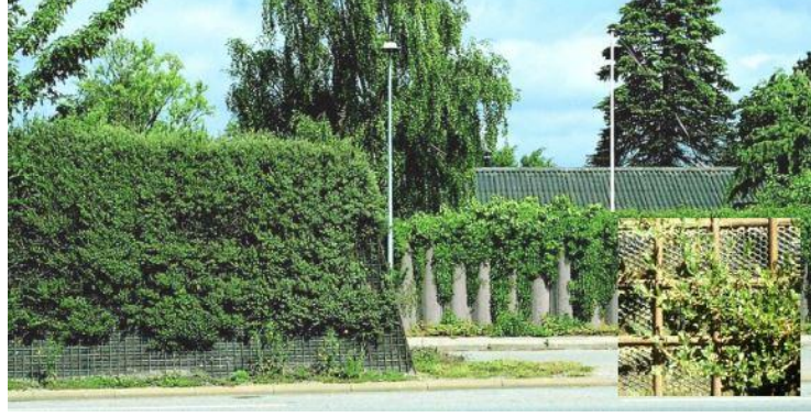
Görsel 4.18. Destekli bio-bariyer açılı duvar uygulaması (Bendtsen, 2009)
