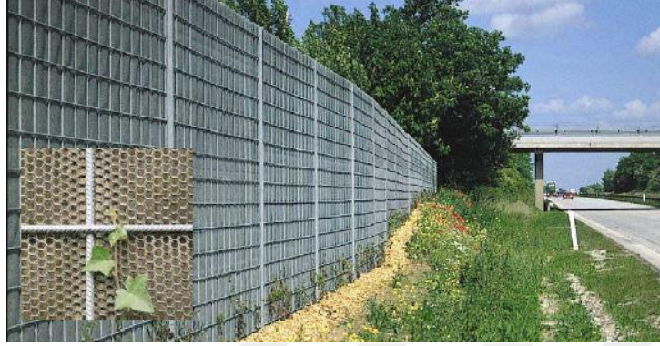
Görsel 4.5. Modüler kafes panel sistem bio-bariyer uygulaması
