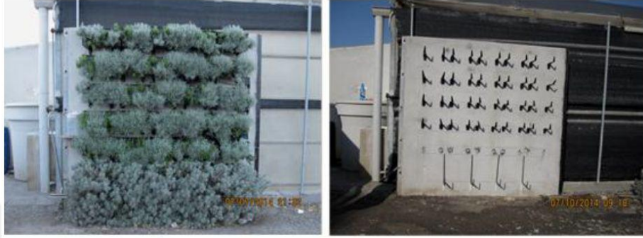
Görsel 4.15. Modüler sistem dikey bahçe uygulaması yapılmış beton bariyer (Lacasta & diğerleri, 2016)
