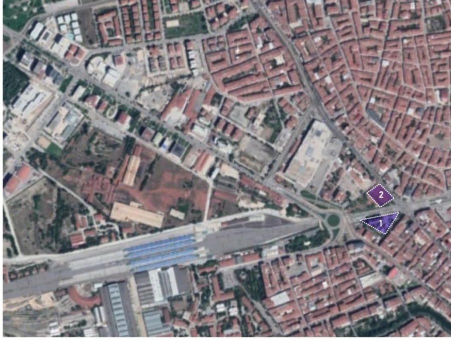
Şekil 2.33. Bölgede Sanayi mirası olarak nitelendirilebilecek yapılar- bölge Günümüz Haritası 1. Toprak Mahsulleri Ofisi, 2. Eskişehir Hal Binası
