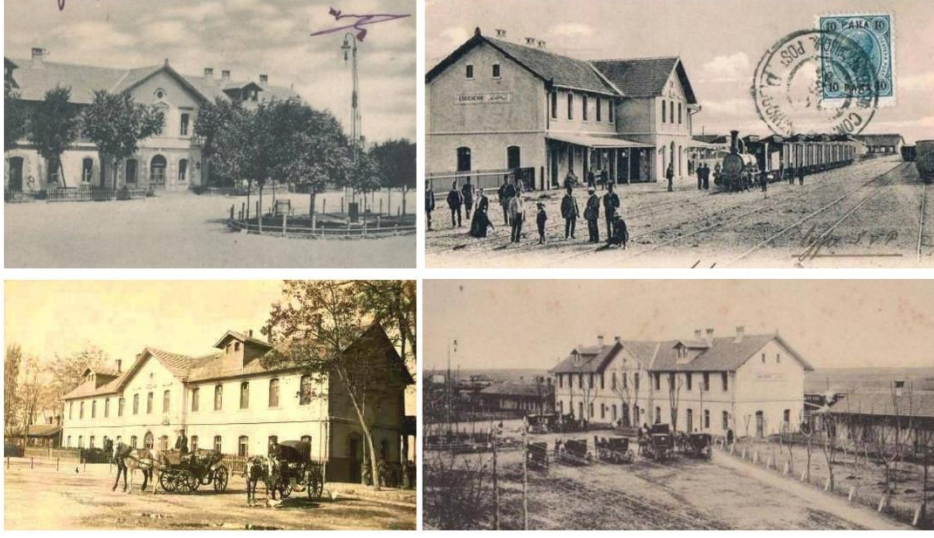
Şekil 2.13. 1892 yılında yapılan Eskişehir Tren istasyonu ( Eskişehir Mimarlar Odası Fotoğraf Arşivi)
