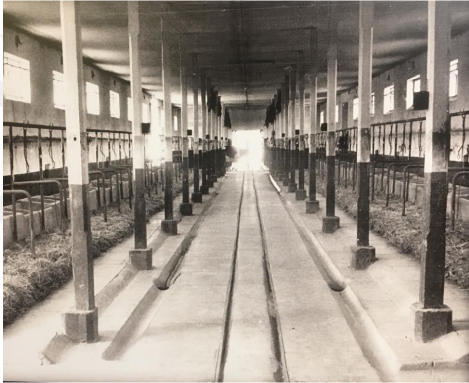
Görsel 4.13. Ahır iç mekân görünüşü (müze arşivi)
