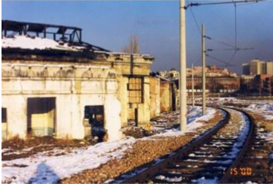
Görsel 4.20. Yarıyı yıkılmış iki birim ve tren yolu hattı ( http-9 )
