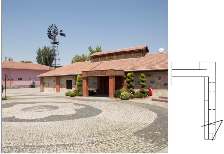
Görsel 4.12. Cephede kullanılan kayrak taş kaplama (kişisel arşiv)
