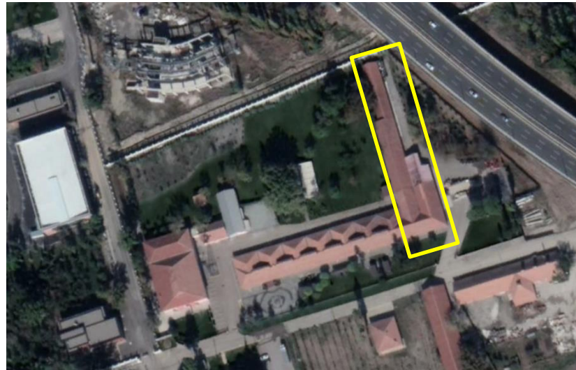
Şekil 4.6. AOC Şarap Fabrikası'na sonradan eklenen kısım ( Google Earth'den alınan görsel yazar tarafından düzenlenmiştir)
