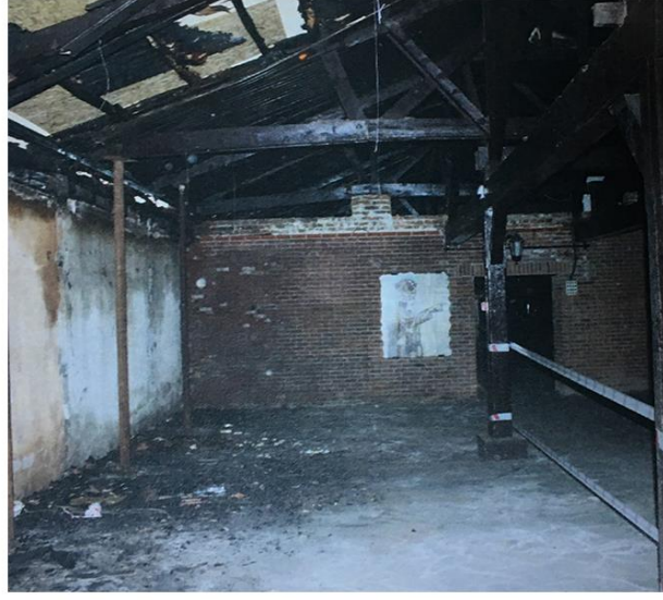
İç Mekan Fotoğrafı - Özgün Durumu-
