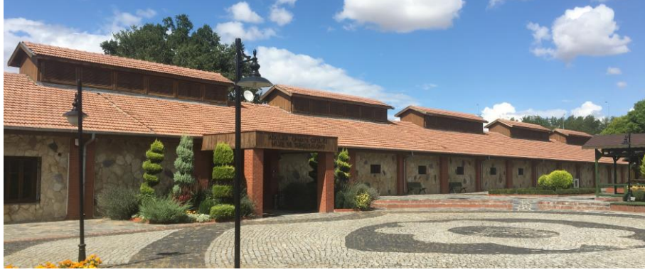
Görsel 4.6. Güney (ön) cephe kapatılan giriş kapısı (kişisel arşiv)
