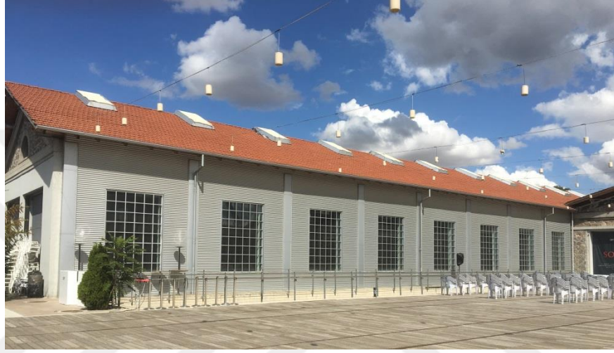
Görsel 4.24. Galeri 4 cephesinin oluklu metal sac kaplaması (kişisel arşiv)
