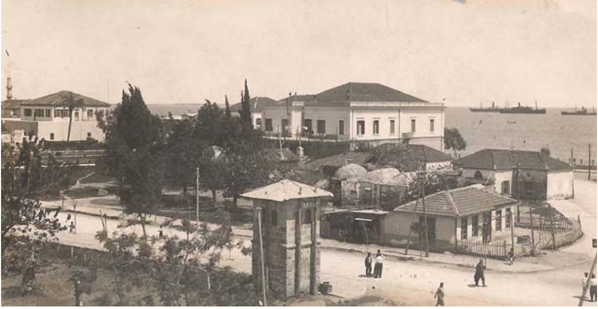
Şekil IV-31: Sursok Hamamı. Hamam, günümüzde Atatürk Müzesi olarak kullanılan Christman Binası'nın kuzeyinde yer almaktadır (Kaynak: Ali Murat Merzeci Koleksiyonu)
