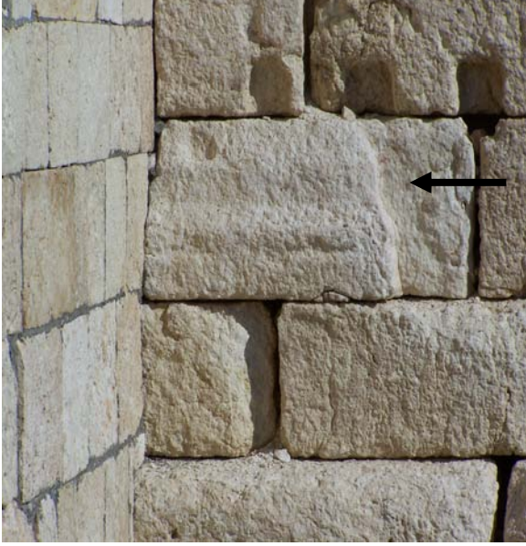
Figür 70: Corycus Taki'nın Kuzeybatı Köşesinde Bulunan Plaster Kaide
