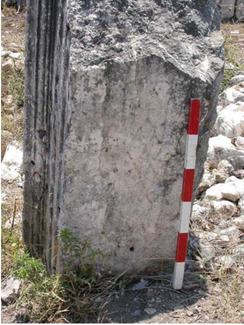
Figür 17: II Numaralı Arşitrav Friz Bloğunun Soffiti
