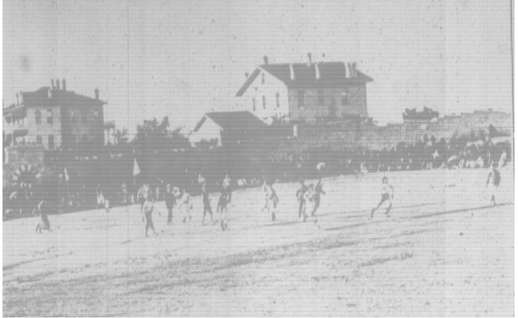
Ek 13: Kolej Futbol Takımı Kaynak: Reel 666, No: 333.
