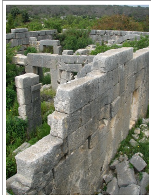
Fig:17, A Yapısı (Dıştan ve içten görünüm)
