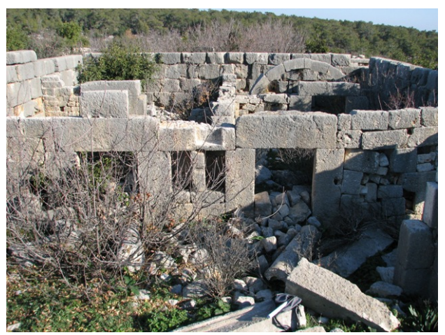
Fig: 18, A Yapısı (içten görünüm).
