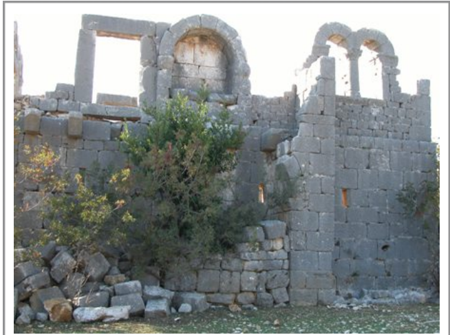
Fig: 9, Çiftlik villası, doğu cephe, balkon terası ve kemerli balkon.
