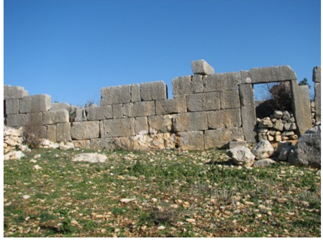
Fig:16, A Yapısı ön (güney) giriş.
