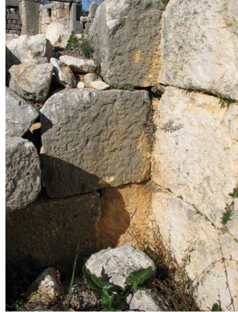
Fig: 13, Kuzey avlu duvarı ve çiftlik villası birleşim köşesi.
