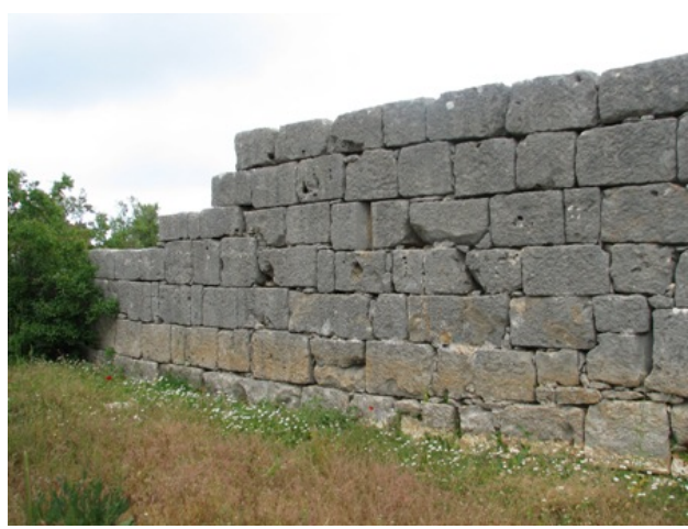
Fig: 21, B Yapısı, dıştan görünüm.
