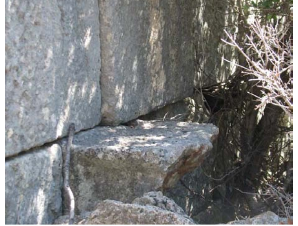
Fig. 24 Özköy Çiftlik Evi üst kat taşıyıcı kemer konsolu
