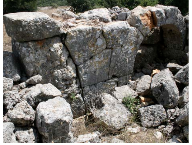
Fig. 9 Özköy Kuleli Çiftlik 1 eklenti oda ve kemerli niş
