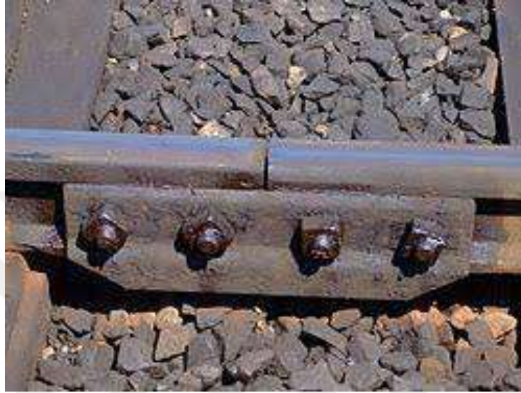
Şekil 2.24. Demir yolu rayı bağlantısındaki sürtünme aşınması
