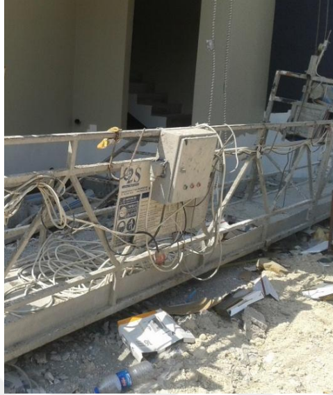
Şekil 2.10. Karşı ağırlıklı asma iskele kumanda kontrol kutusu.
