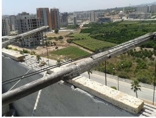
Şekil 4.6. Aşırı yük mekanizması olmayan asma iskele
