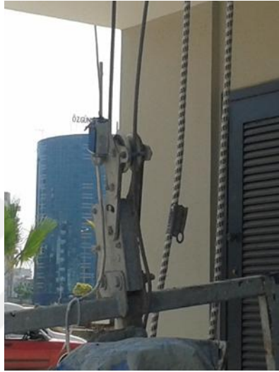
Şekil 2.12. Karşı ağırlıklı asma iskele sistemi halat sonu sınır anahtarı
