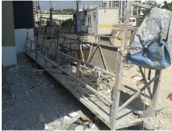
Şekil 4.26. Eğim algılayıcı mekanizma olmayan asma iskele
