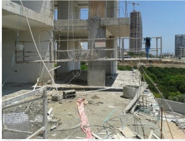
Şekil 4.2. Halat gergi ağırlıkları olmayan asma iskele
