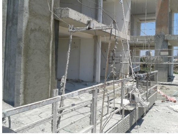
Şekil 4.5. Emniyet freni ve emniyet çelik halatı olmayan asma iskele
