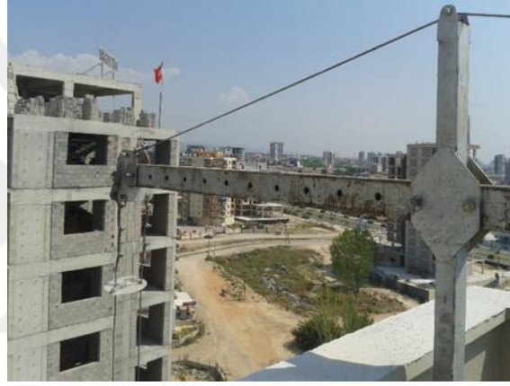
Şekil 4.22. Asma iskele çatı konsolları ve bağlantı elemanları
