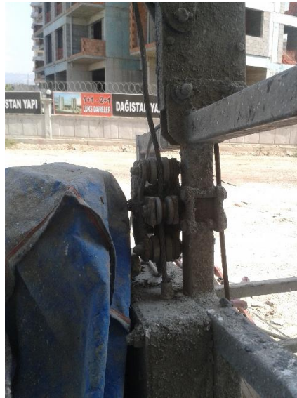
Şekil 4.24. Asma iskele aşırı yük mekanizması
