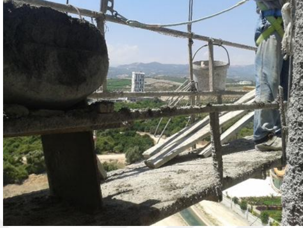
Şekil 4.11. Halat gergi ağırlıkları olmayan asma iskele
