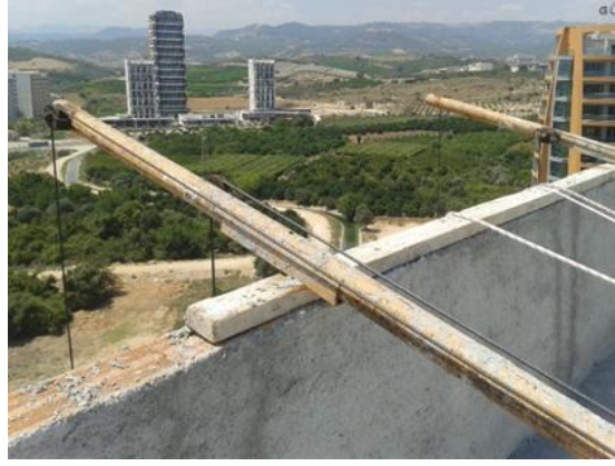
Şekil 4.13. Asma iskele çatı konsolları, makaralar ve bağlantı elemanları
