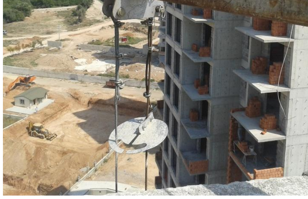
Şekil 2.8. Karşı ağırlıklı asma iskele sistemi emniyet çelik halatları
