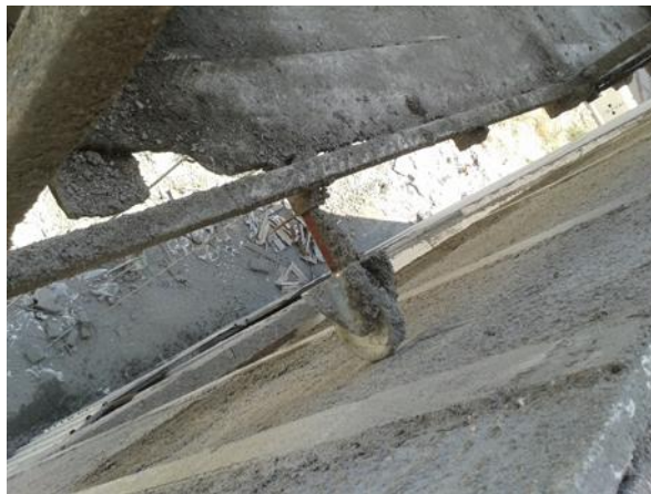
Şekil 2.13. Karşı ağırlıklı asma iskele sistemi cephe tekerleri
