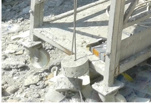
Şekil 4.11. Halat gergi ağırlıkları olmayan asma iskele
