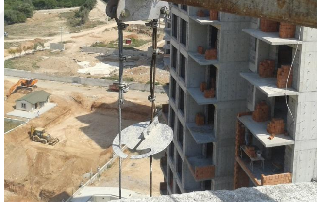
Şekil 2.7. Karşı ağırlıklı asma iskele sistemi motor (tırmanma) çelik halatları
