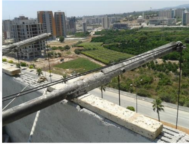
Şekil 4.4. Asma iskele çatı konsolları, makaralar ve bağlantı elemanları
