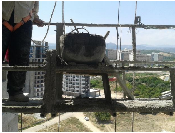
Şekil 4.14. Emniyet freni ve emniyet çelik halatı olmayan asma iskele
