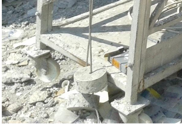
Şekil 4.2. Halat gergi ağırlıkları olmayan asma iskele
