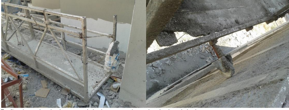
Şekil 4.25. Cephe tekeri olmayan iskele ve cephe tekeri olan iskele
