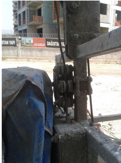
Şekil 2.11. Karşı ağırlıklı asma iskele sistemi aşırı yük mekanizması
