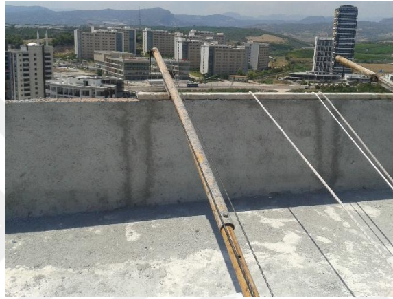
Şekil 4.15. Aşırı yük mekanizması olmayan asma iskele
