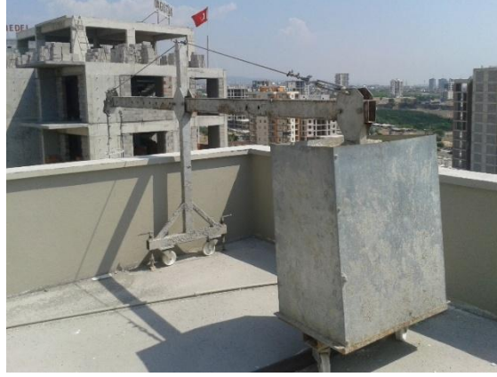
Şekil 2.6. Karşı ağırlıklı asma iskele mobil askı sistemi
