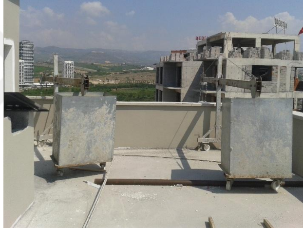
Şekil 2.9. Karşı ağırlıklı asma iskele sistemi karşı yükleri
