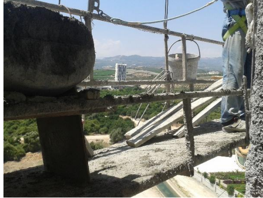
Şekil 4.16. Sınır anahtarı, cephe tekeri, yük levhası, eğim algılayıcısı olmayan asma iskele
