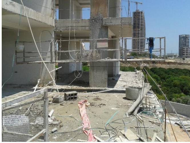
Şekil 4.7. Sınır anahtarı, cephe tekeri, yük levhası, eğim algılayıcısı olmayan asma iskele
