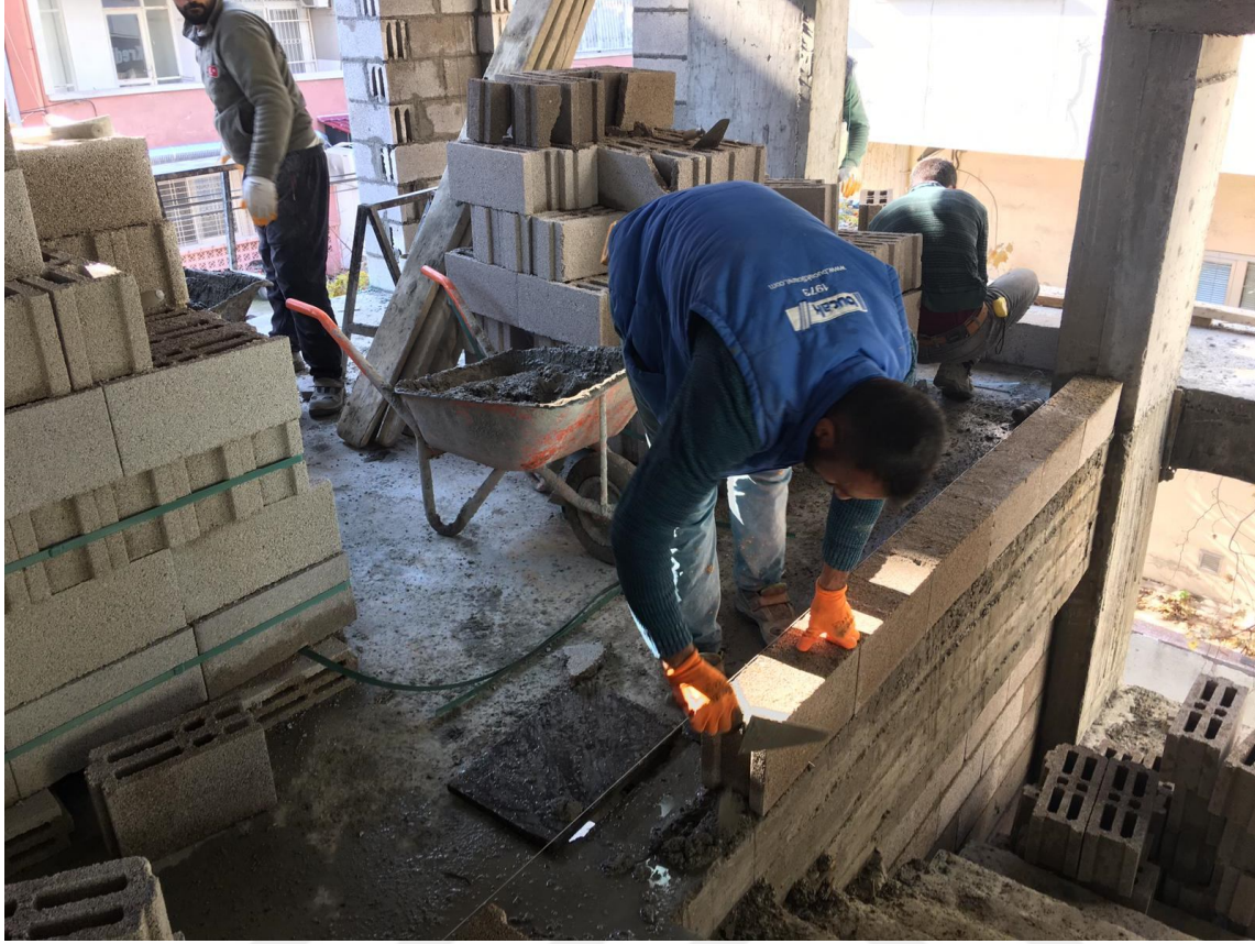
Resim 4.7 Duvar İşçiliği – Eğilerek Çalışma
