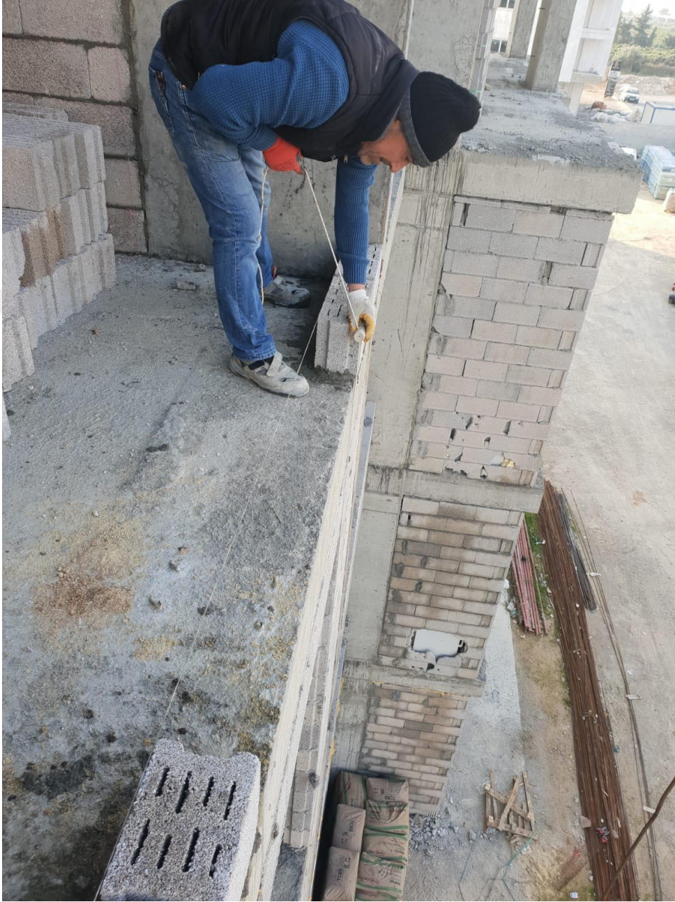
Resim 4.9 Duvar İşçiliği – Çömelip Kalkarak Çalışma
