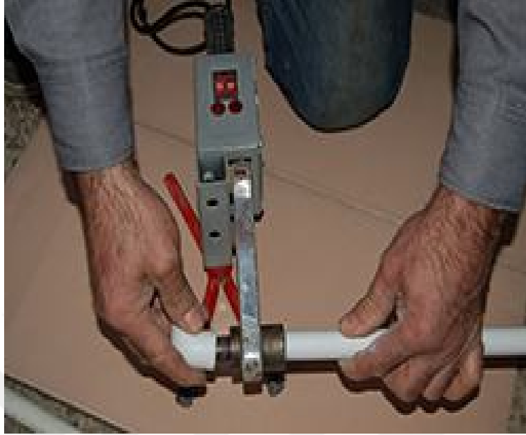
Resim 4.11 Tesisat İşçiliği – Çömelerek Yere Doğru Çalışma
