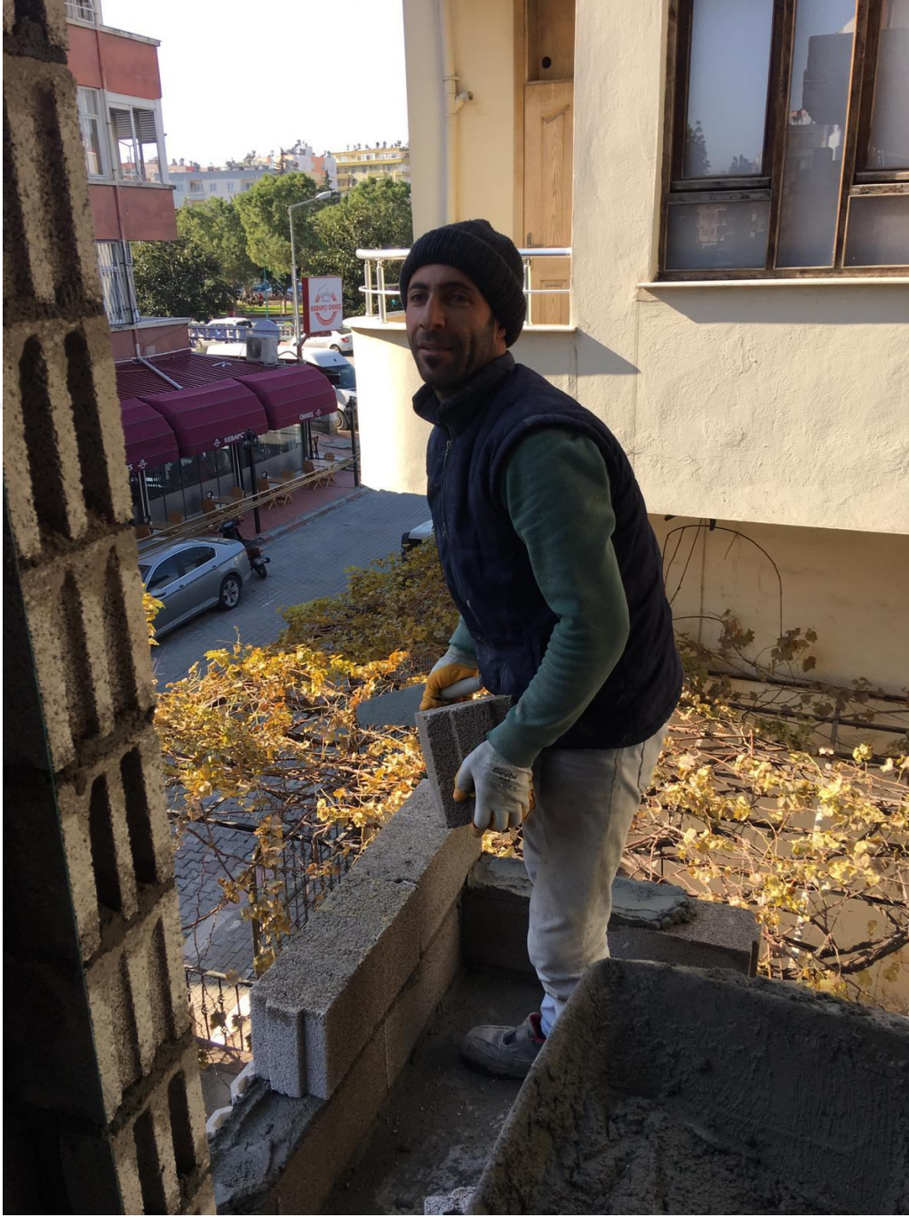
Resim 4.8 Duvar İşçiliği – Ayakta Çalışma
