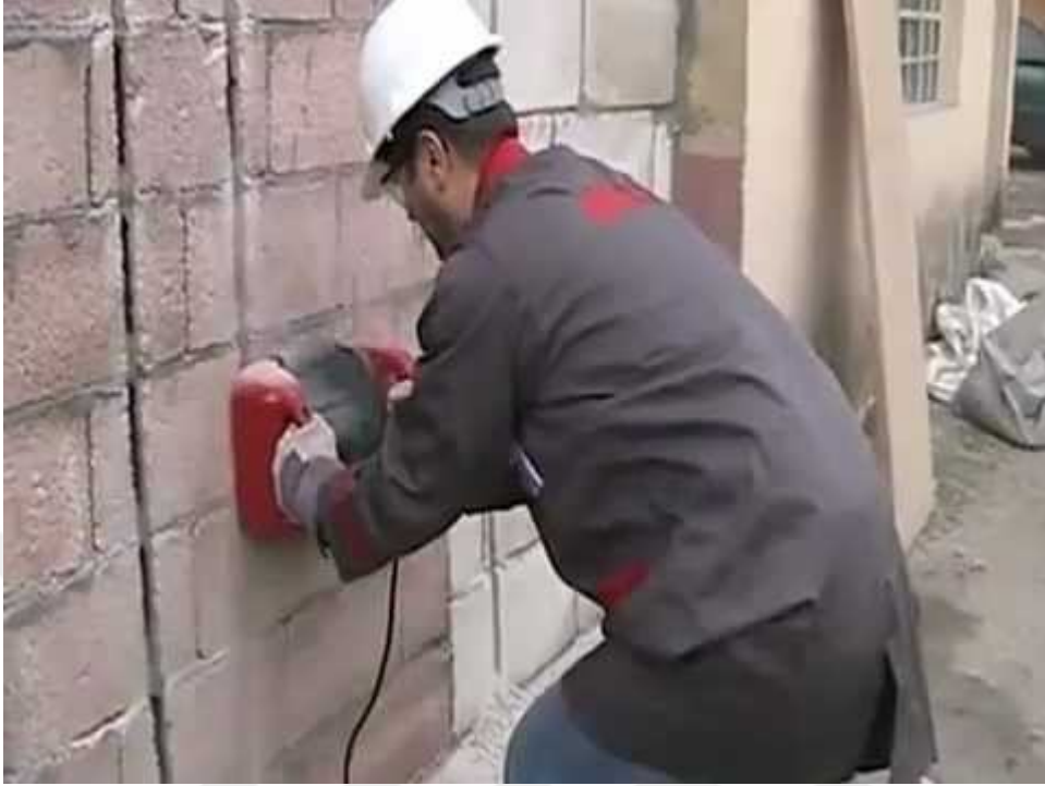
Resim 4.10 Tesisat İşçiliği – Eğilerek Kalkarak Çalışma
