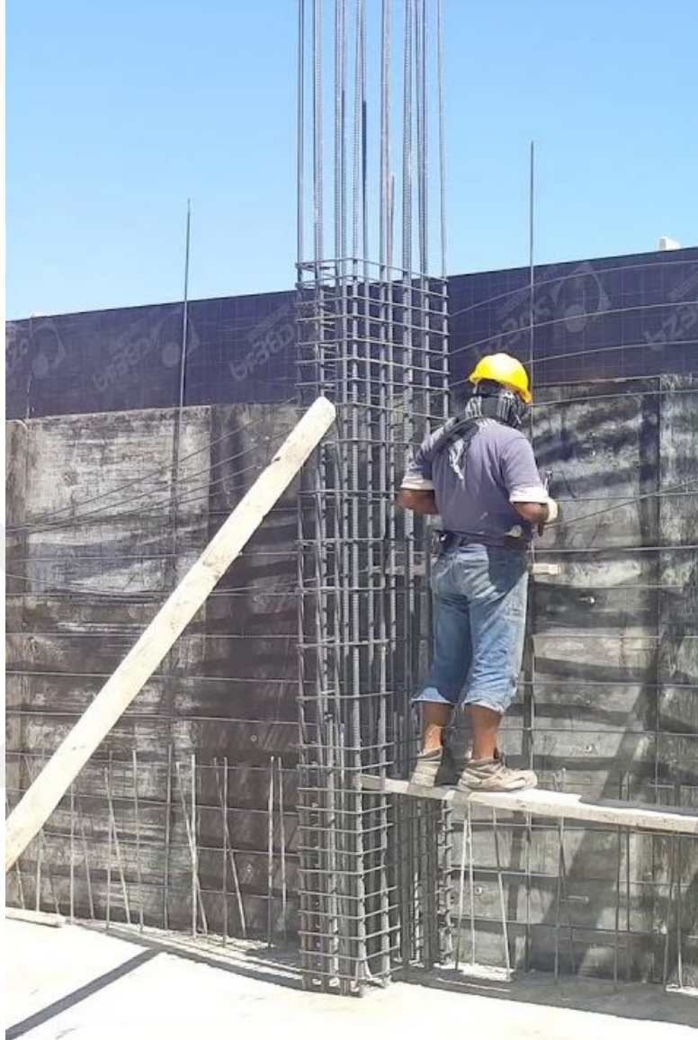
Resim 4.6 Demir işçiliği – İskele Üzerinde Dik Çalışma
