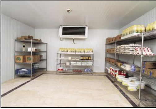
Resim 2: Kuru Hava Deposu
