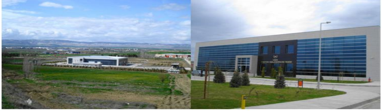
Şekil 3.6. TAEK Proton Hızlandırıcı Tesisi
