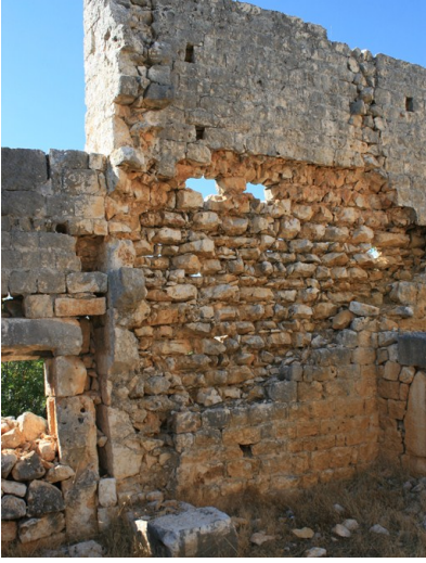
Fig. 101 Karakabaklı 1 Nolu Konut, duvar örgüsü
