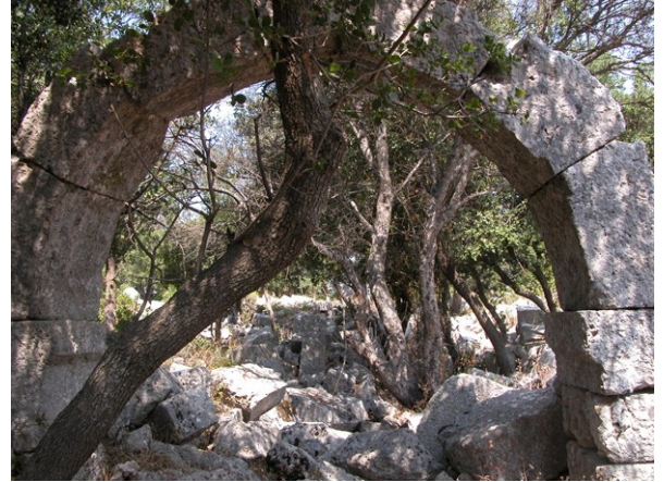
Fig. 59 Hüsametli Çildiremez Çiftlik Evi içerisindeki kemer
