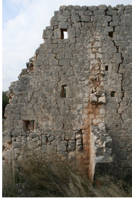
Fig. 149 Kanytella 9 Nolu Konut, Mekân 3'ün duvarında bulunan hatıl delikleri
