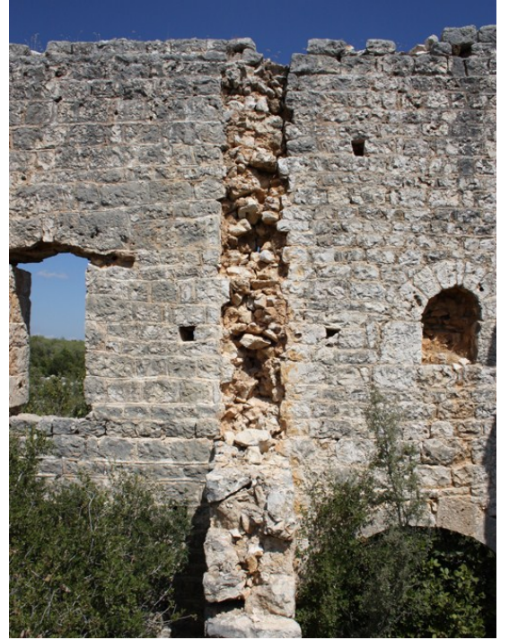
Fig. 127 Karakabaklı 7 Nolu Konut, duvar örgüsü
