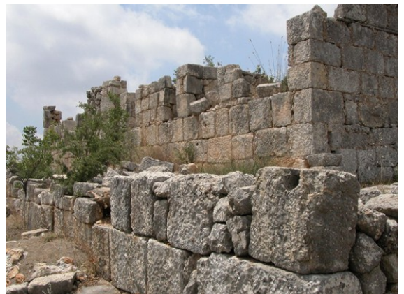
Fig. 70 Keşlitürkmenli Çiftlik Evi, duvar örgüsü
