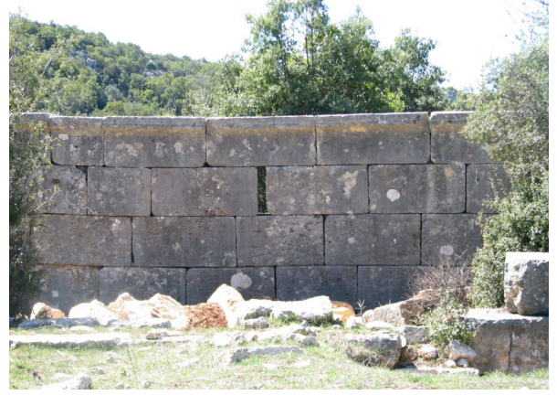
Fig. 72 Özköy Çiftlik Evi, duvar örgüsü ve mazgal (Alıntı Yeri: Mörel, 2010: 22)
