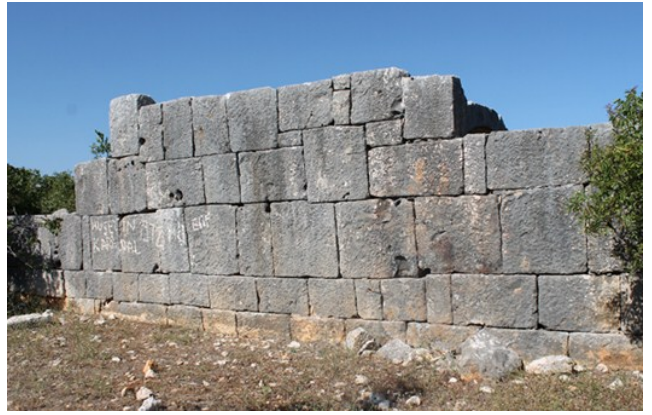
Fig. 114 Karakabaklı 4 Nolu Konut, duvar örgüsü
