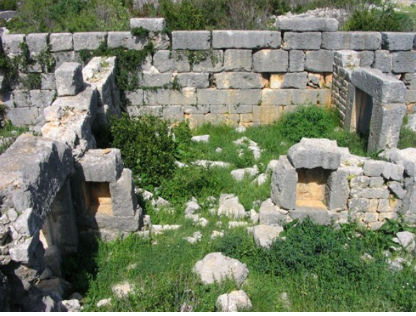
Fig. 92 Karakabaklı 3 Nolu Konut, iç mekân kapılar ve nişler
