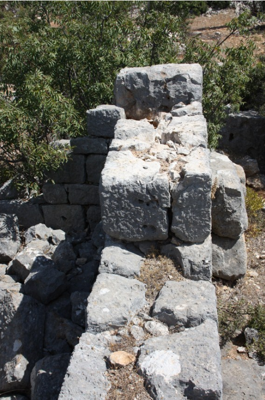
Fig. 118 Karakabaklı 6 Nolu Konut, duvar örgüsü
