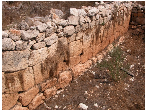
Fig. 60 Hüsametli Çildiremez Çiftlik Evi, duvar örgüsü
