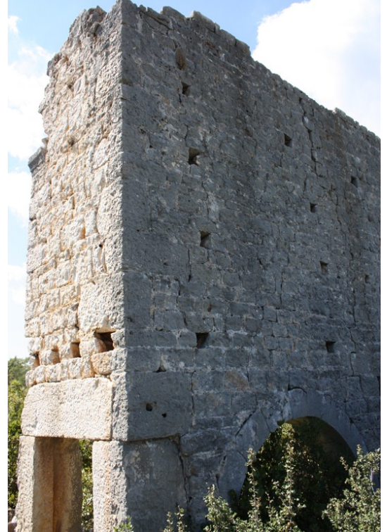
Fig. 123 Karakabaklı 7 Nolu Konut, giriş kapıları
