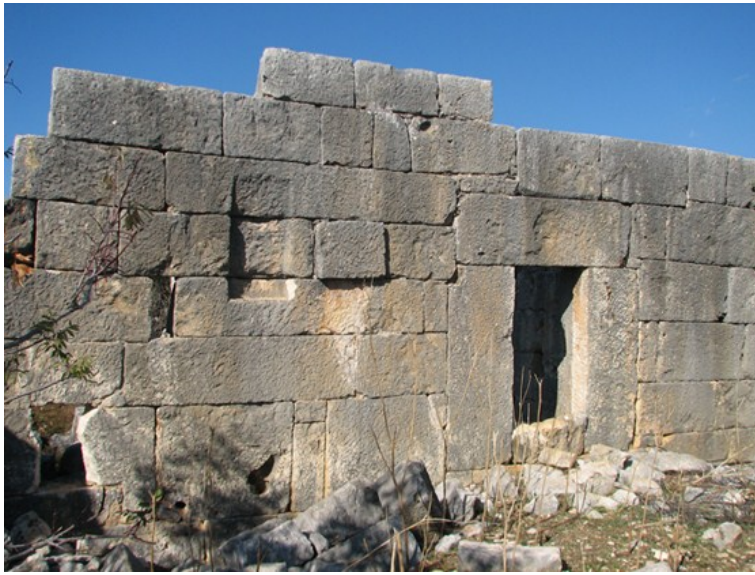
Fig. 94 Karakabaklı 3 Nolu Konut, duvar örgüsü
