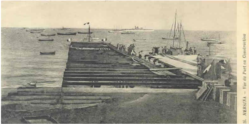
Fotoğraf 5- Kaynak: www.mersinport.com.tr , Mersin Limanında Gümrük İskelesinin yanına inşa edilen yeni iskele inşaatı.
