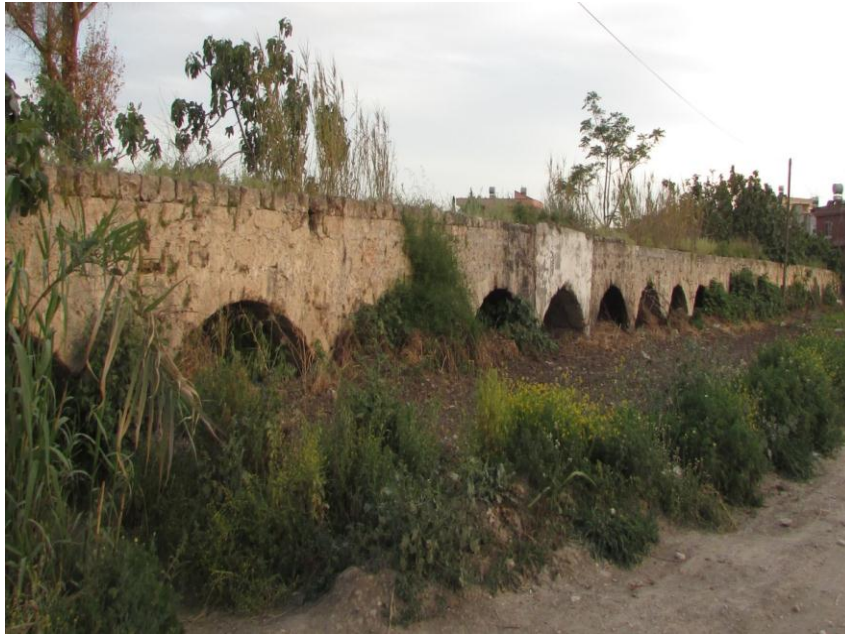
Figür 4. Karaduvar'da Bulunan Su Kemerleri
