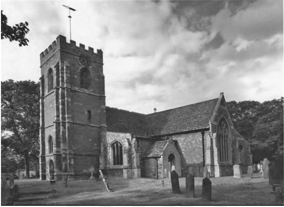
Yapımına Kara Ölüm'den önce başlanan ve salgın günlerinde inşaatı duran ve sonrasında ise ustaların ölmesiyle sert-dikey mimari tarzda(perpendicular) yapılan Medbourne Kilisesi (Leicestershire).
