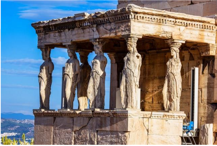
Resim 12: Erekhtheion Tapınağı Güney Cephesi Karyatidleri
