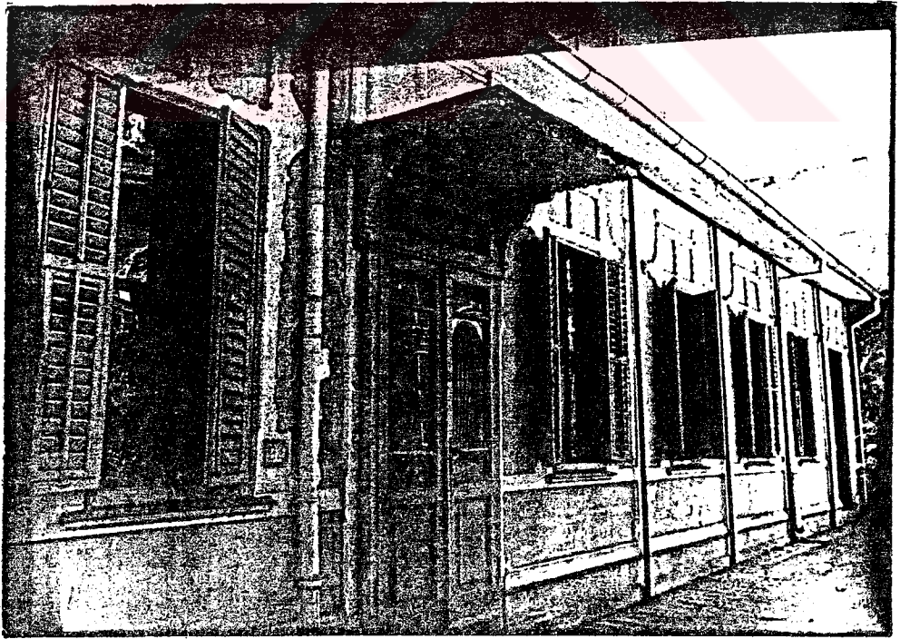
Res .16 Küçük Pavyon giriş cephesi
