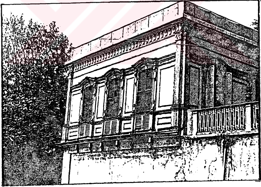
Res.32 Seyir/Set Kioskü cadde cephesi
