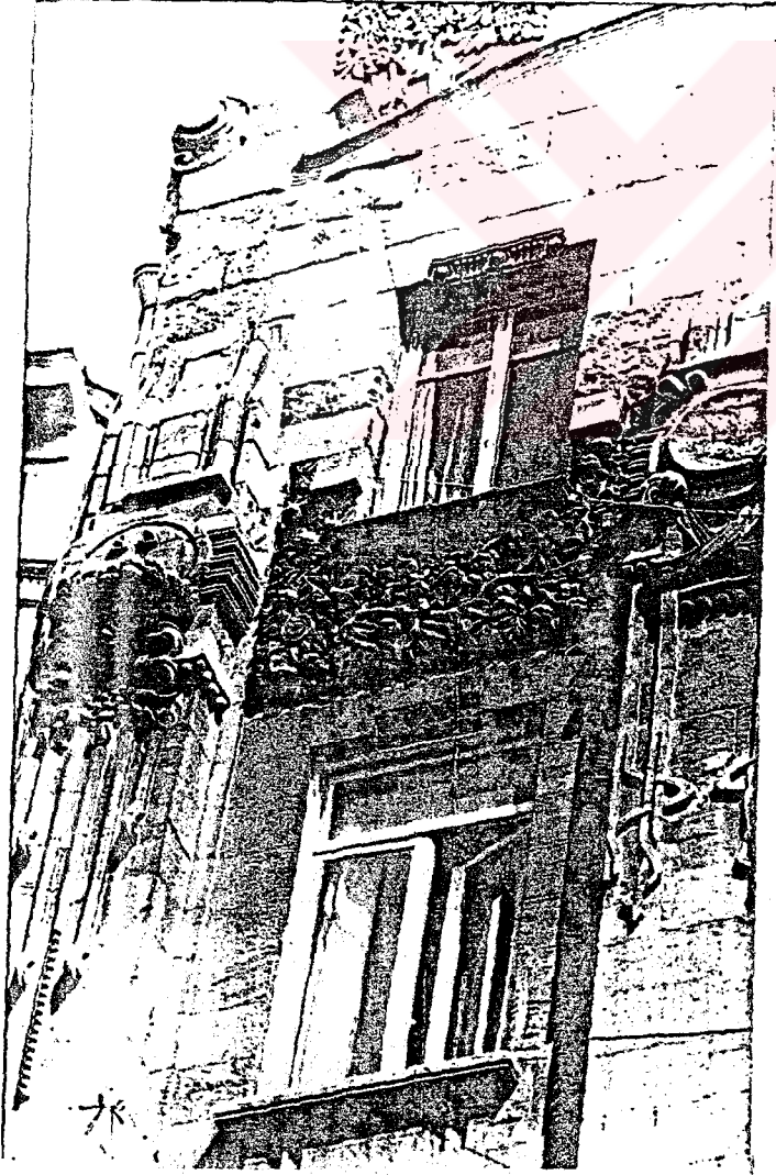
Res.169 Botter apartmanı cephe ayrıntısı
