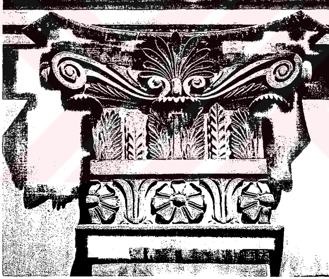
Resim 152 II. Mahmud Türbesi, Cephe süslemesinden detay
