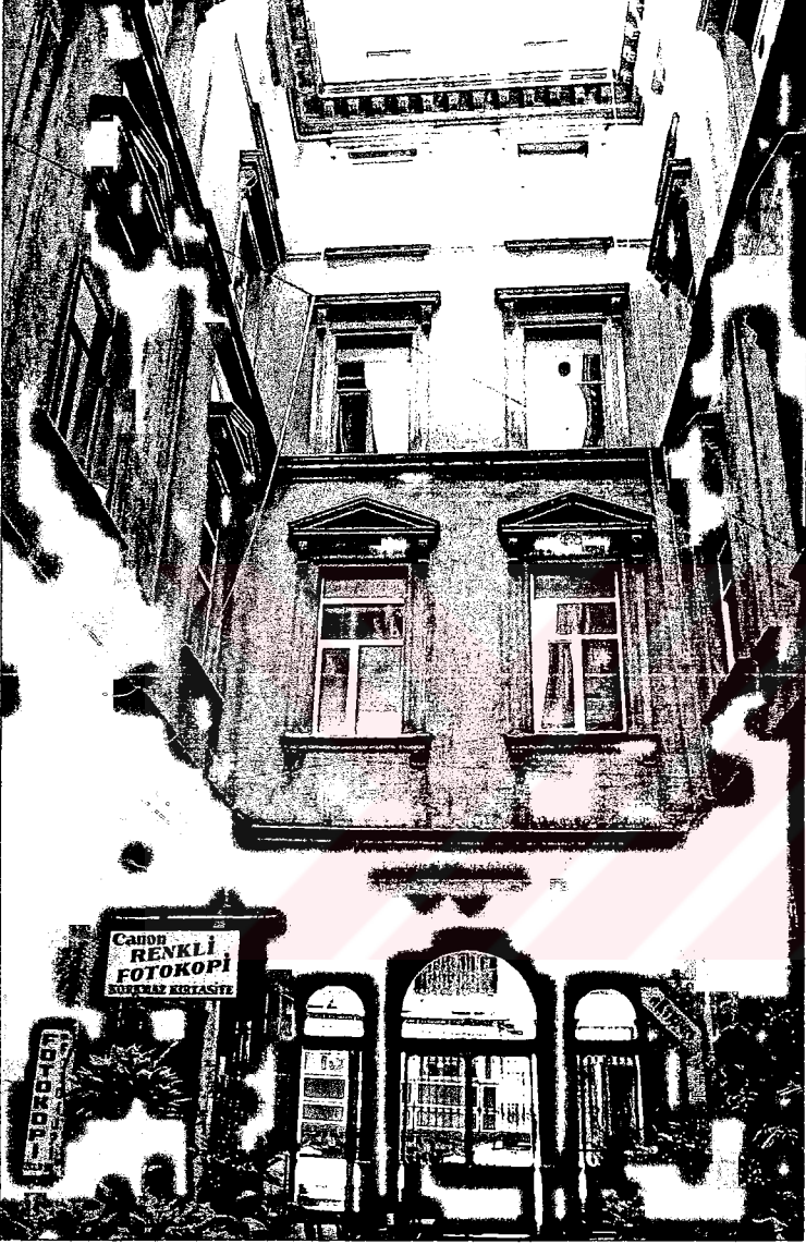
Resim 81 Tünel Pasajının içinden bir görünüm
