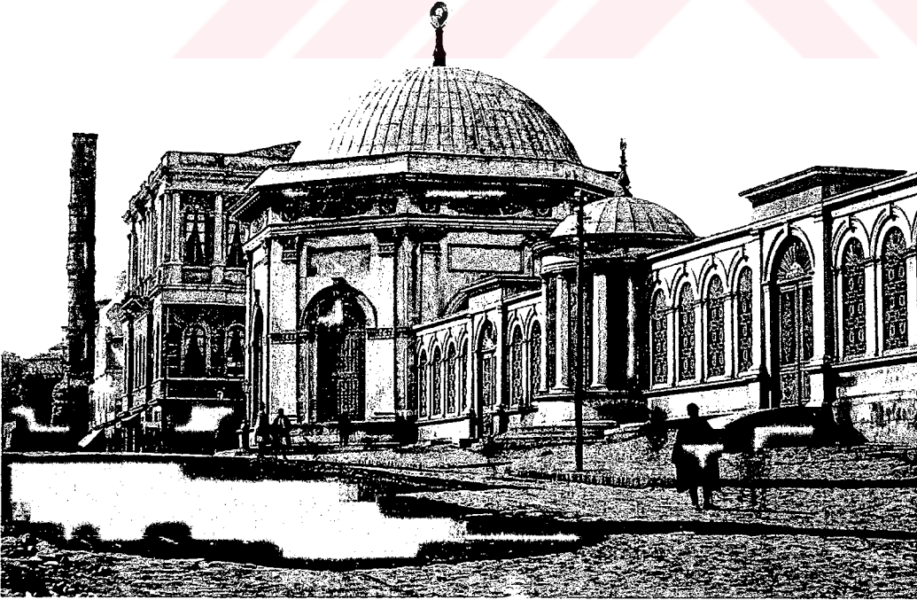
Resim 149 1880'de II. Mahmud Türbesi
