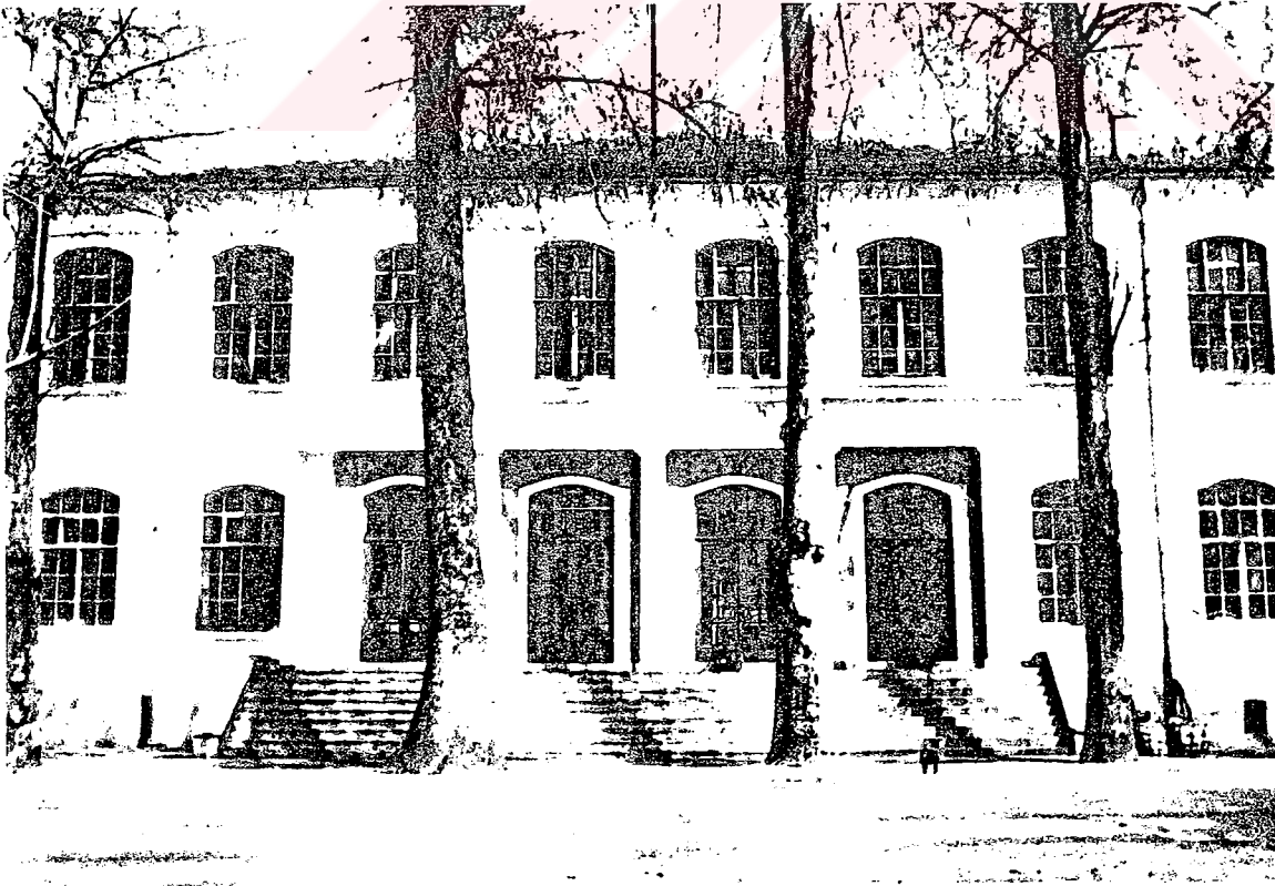
Resim 137 Hereke Fabrika-i Hümayunu, Deniz Cephesi.
