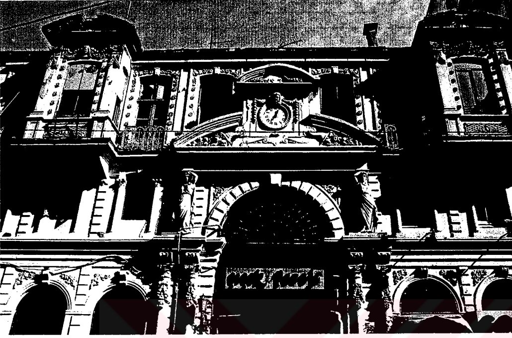
Resim 76 Çiçek Pasajı, İstiklâl Caddesi'ne açılan cephe
