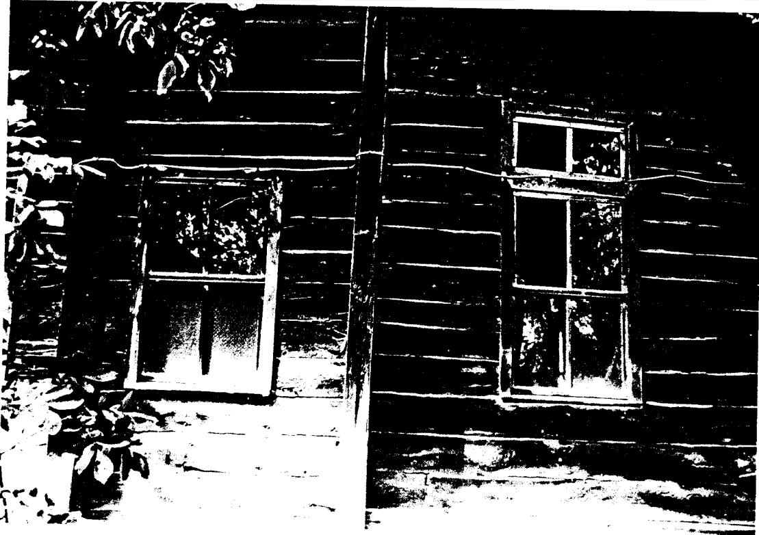
32. Güney cepheden doğu yan mekana ve harime açılan pencereler
