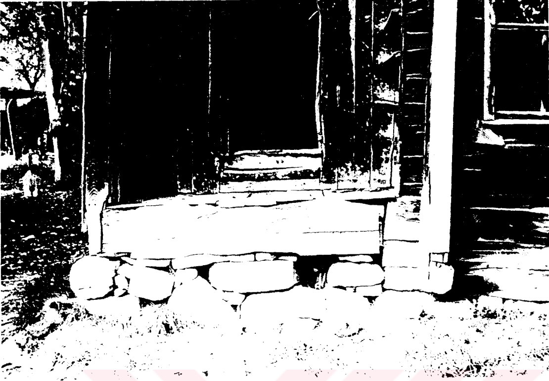
33. Güney cephede beden duvarlarının oturduğu taş duvar
