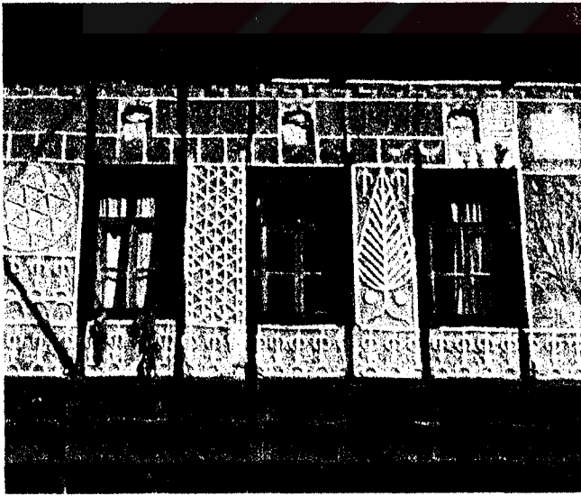
Resim 3. 209. Safranbolu Evi Dış cephesi
