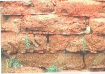
Resim: 18 Duvar örgüsünde, yapı elemanı olarak kerpiç kullanımı, Çayönü projesi
