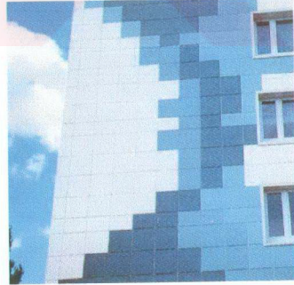
Resim: 111 Üç ayrı tek renk karonun bina dış cephe kaplama malzemesi olarak kullanımı
