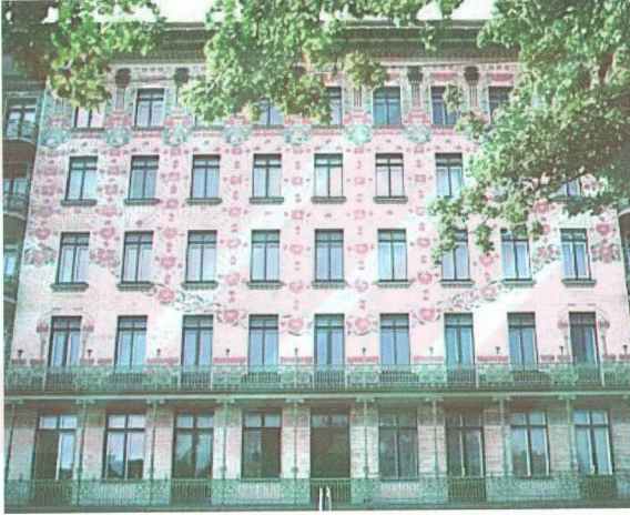
Resim: 96 Dış cephede mayolika karo kullanımı Yapı: Mayolika kaplamalı ev, 1898, Art Nouveau dönemi, Avusturya Mimar: Otto Wagner
