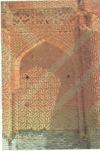
Resim: 81 Yapı ve kaplama malzemesi olarak sırsız tuğla kullanımı, Selçuklu dönemi, 11.yy., Selçuklu türbesi, İran
