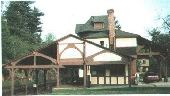
Resim: 87 Yapı: Sırsız tuğla, ahşap ve metalin yapı malzemesi olarak kullanımı, Victorian Dönemi, Baltimore istasyonu, 1886 Mimar: Frank Furness
