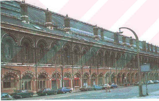
Resim: 86 Yapı: Sırsız tuğla ve taşın yapı malzemesi olarak kullanımı, Victorian Dönemi, St. Pancras istasyonu, 1868 Mimar: William Henry Barlow
