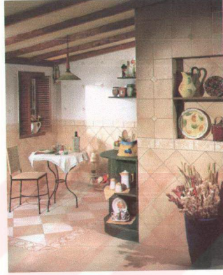
Resim: 109 Fon, dokulu fon, merkez desen, bordür, takoz karoların mutfakta, iç mekan yer ve duvar kaplama malzemesi olarak kullanımı.
