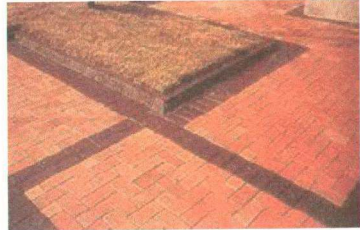
Resim: 72 Klinker tuğla ile döşeli zemin.
