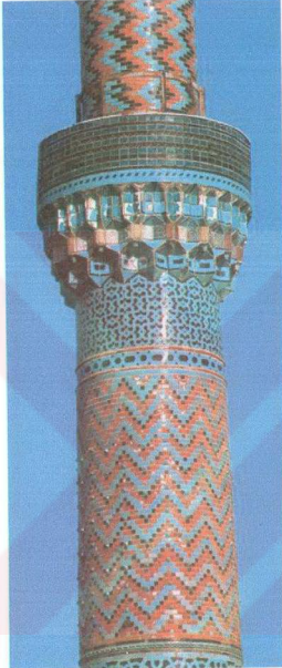
Resim: 32 Kaplama malzemesi olarak sırlı tuğla kullanımı, Yeşil Cami, 1392, Iznik
