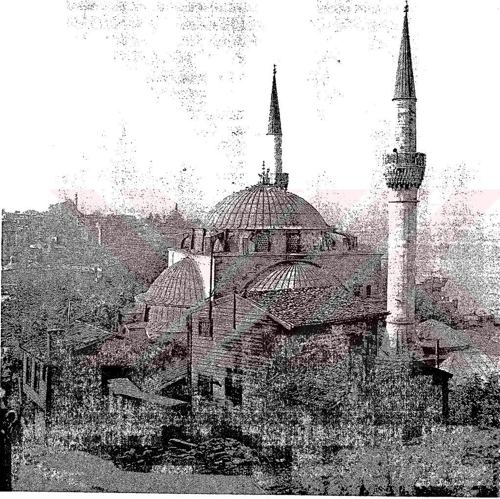
48. Mihrimah Sultan Camii'nin güney-doğu köşesinden görünümü. (Goodwin'den)
