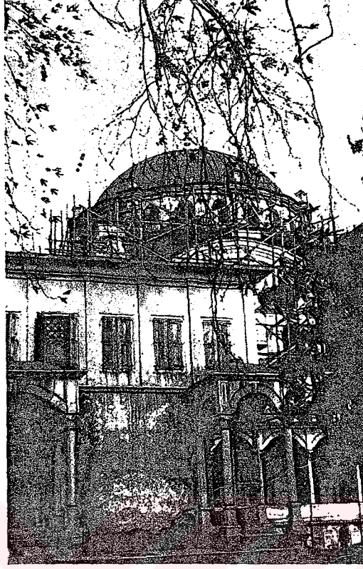
179. Selimiye Camisi'nin kubbesi onarım sırasında. (1960. V.G.M.A.)
