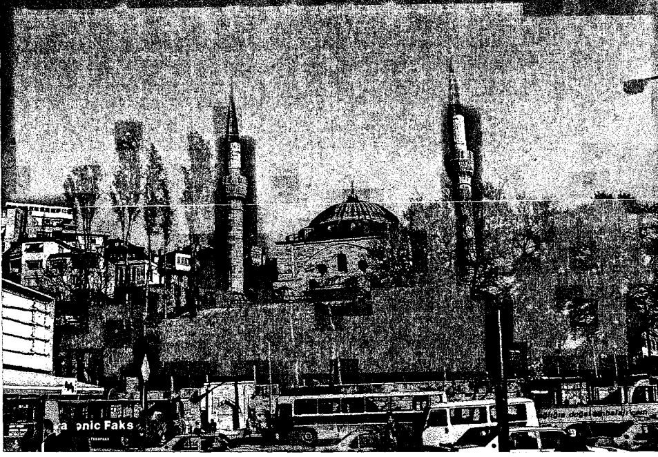
55. Mihrimah Sultan Camii'nin kuzey cephesi ve son cemaat yeri.
