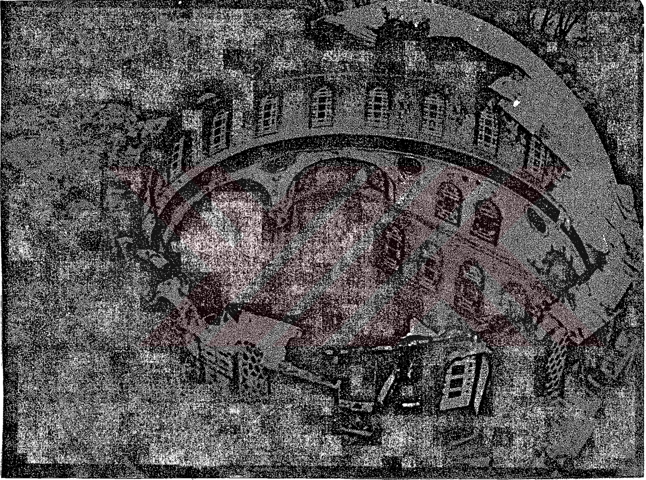
169. Beylerbeyi Camisi'nin bir yangın sonucu çöken kubbesi. (1983, V.G.M.A.)
