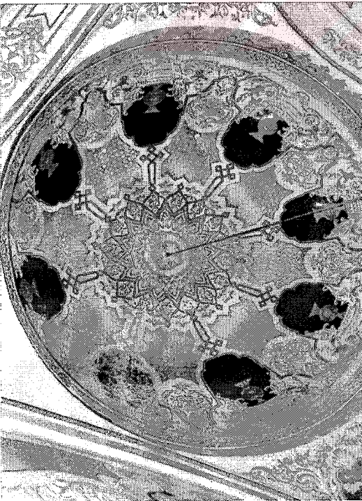
Hüseyin Mehmed Paşa Türbesi Kubbe İç Sathı (47)
