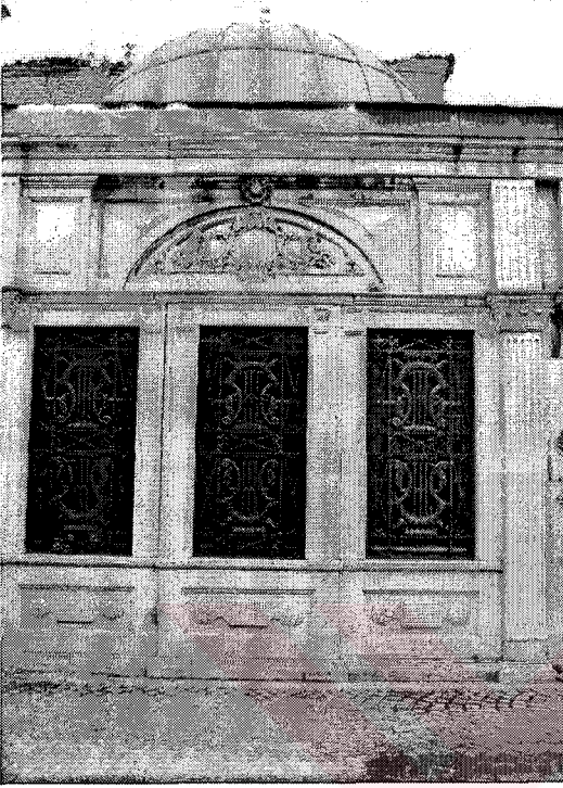
Hüseyin Mehmed Paşa Türbesi Dış Görünüm (45)
