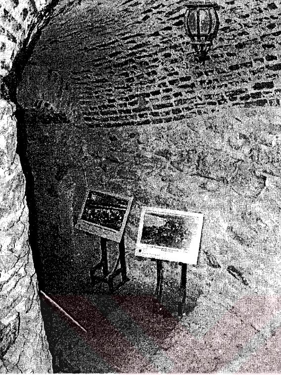
Resim 3.121 : Kiyık Tabya, topçu odası, kavisli giriş dehlizi
