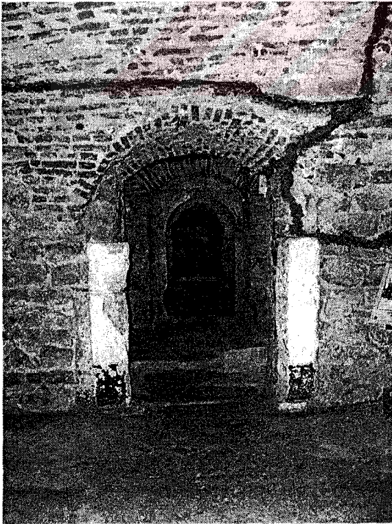
Resim 3.126 : Kiyık Tabya, Karargah binası, ara kapılar
