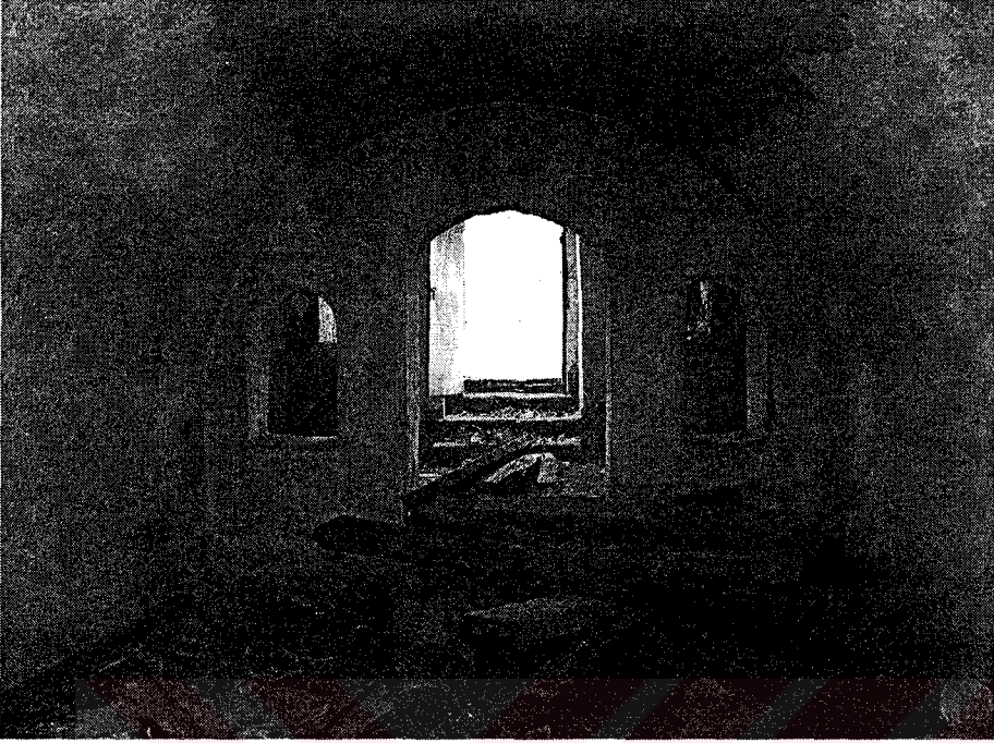
Resim 3.139: Demirtaş Tabya, koğuş girişi, iç mekandan görünüş
