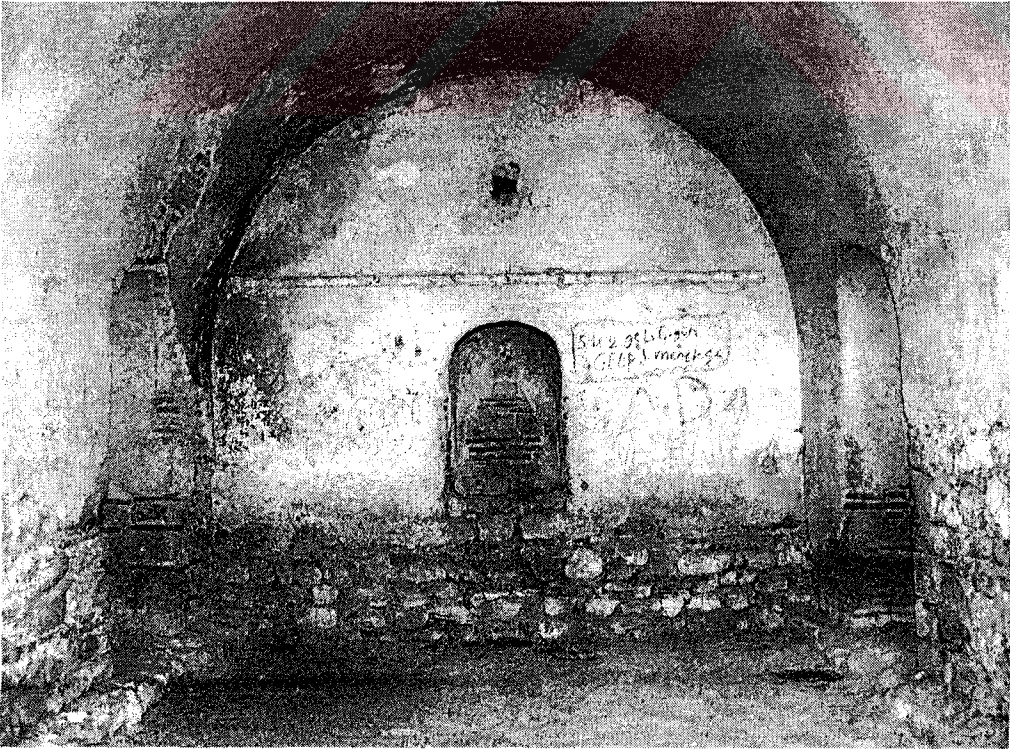
Resim 3.10 : Hıdırlık Tabyası, koşukapı, iç mekan
