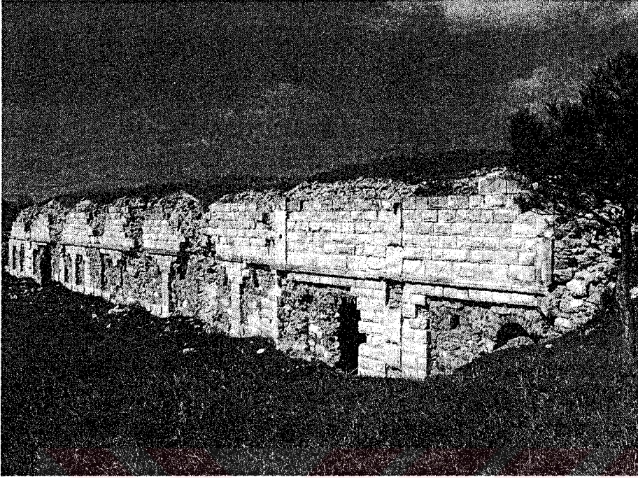
Resim 3.71 : Büyük Taş Ocağı Tabya, koğuş binası
