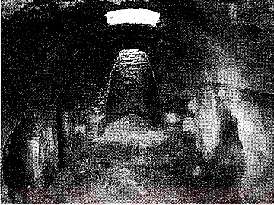
Resim 3.49: Başhöyük Tabya, mutfak bölümü, iç mekan
