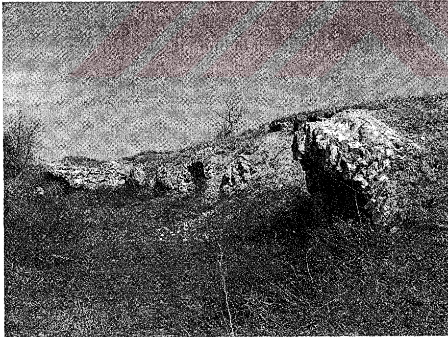
Resim 3.86 : Ayvazbaba Tabyası, karargah binası
