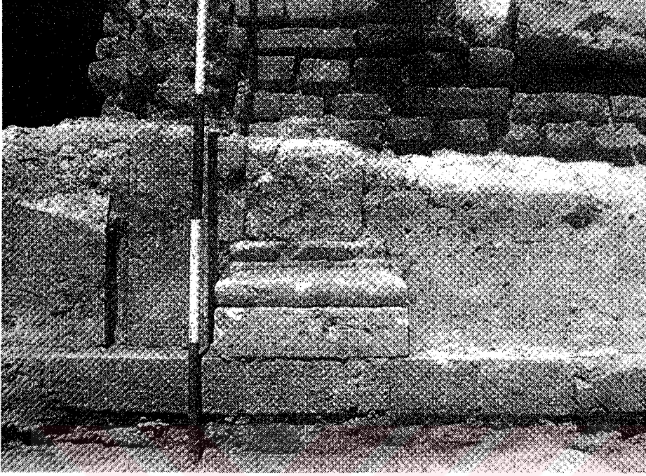
Resim 3.15 : Hıdırlık Tabyası, koğuş binasının cephesindeki taş kaplama izleri
