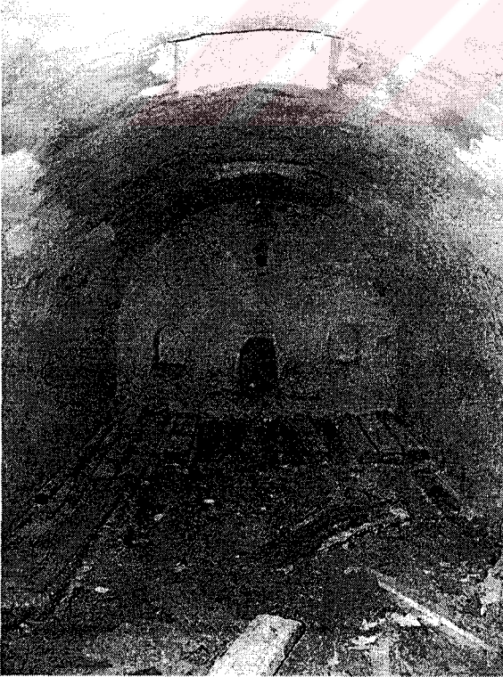
Resim 3.138: Demirtaş Tabya, koğuş, iç mekan
