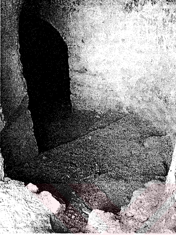
Resim 3.115: Topyolu Tabya, topçu odası, kavisli giriş dehlizi
