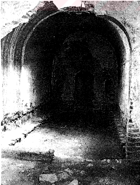
Resim 3.6 : Hıdırlık Tabyası, Giriş binası, iç mekan
