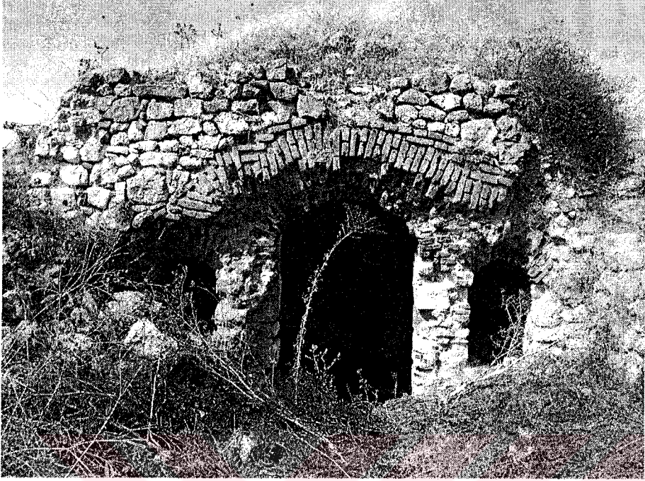
Resim 3.41 : Kemerler Tabya, koğuş, giriş cephesi
