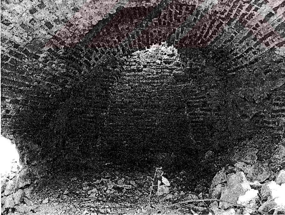
Resim 3.88 Ayvazbaba Tabyası, karargah binası, mutfak bölümü
