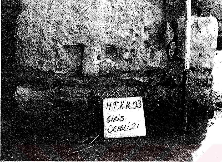
Resim 3.21 : Hıdırlık Tabyası, Edirne suruna ait kenetli taş blok
