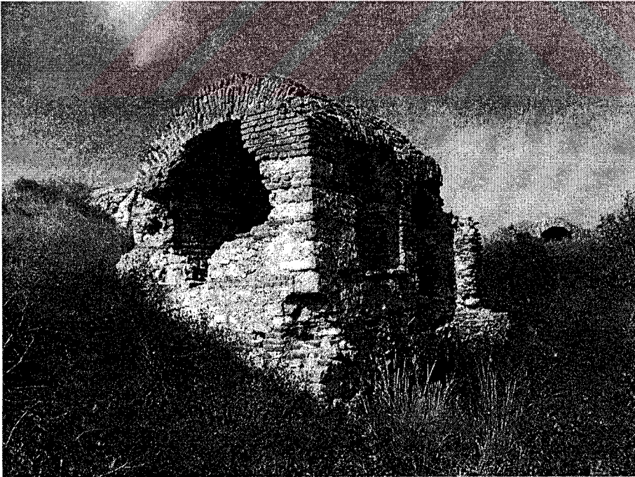
Resim 3.24 : Abdurrahman Ağa Tabyası, karargah binası
