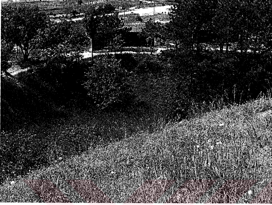
Resim 3.107: Kestanelik Tabya, hendeğin güney-doğu köşesinden görünüş
