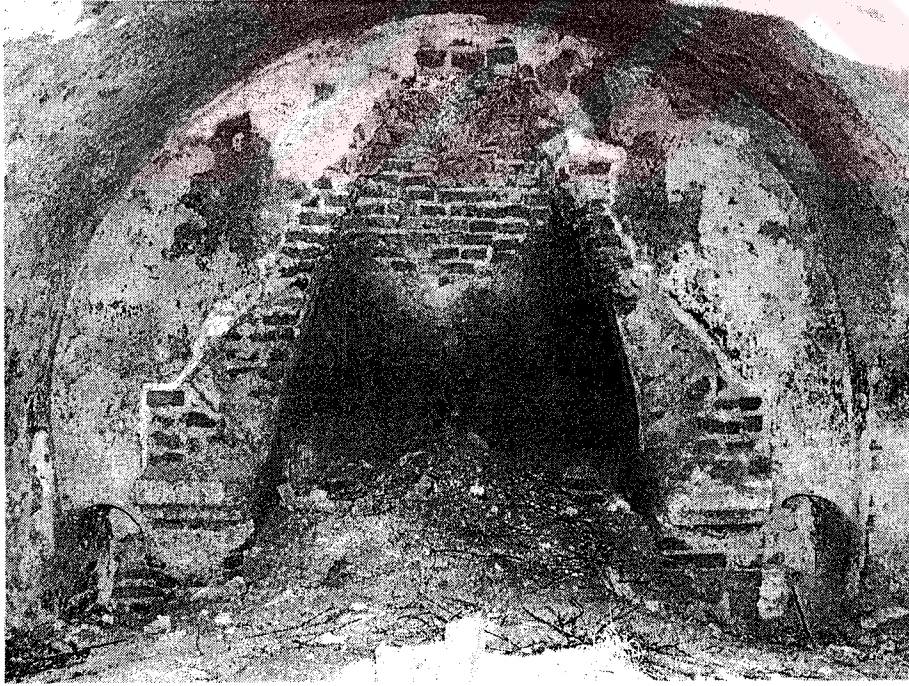
Resim 3.44 : Kemerler Tabya, mutfak bölümü, iç mekan
