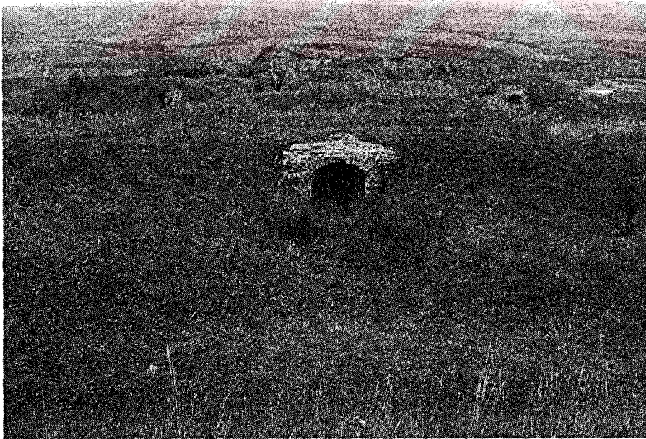
Resim 3.84 Ayvazbaba Tabyası, bölümler arası bağlantıyı sağlayan dehliz.
