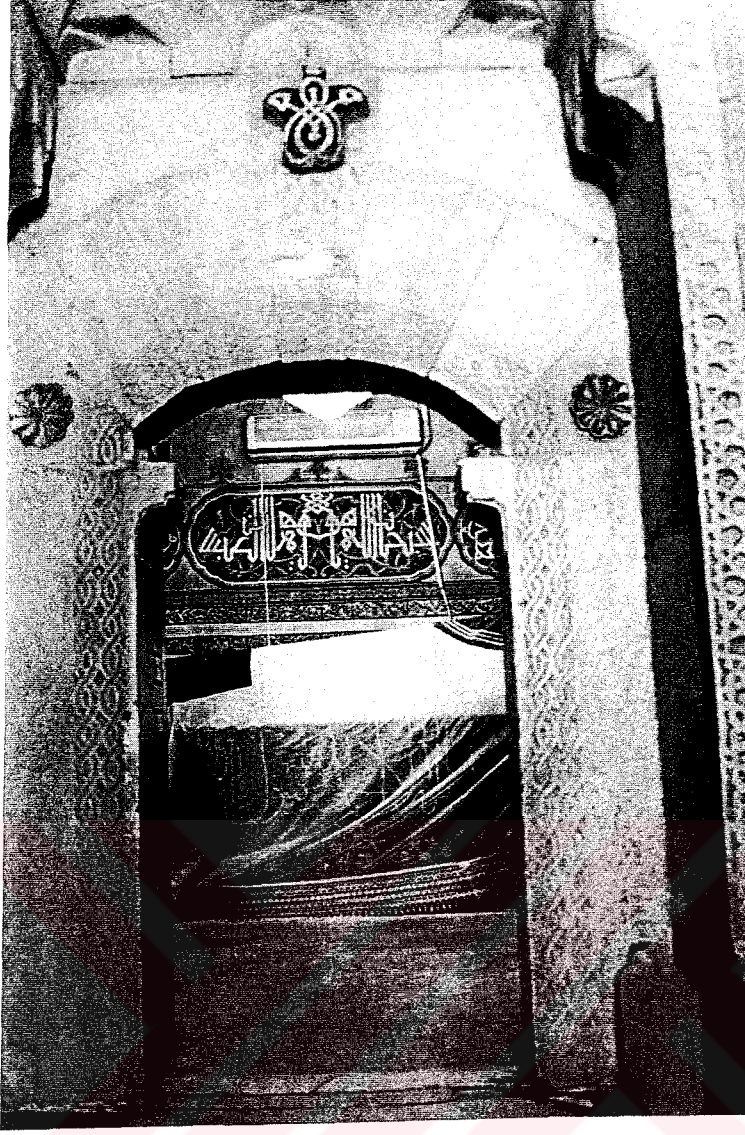
Resim 82. Hacı Bektâş-ı Veli Türbesi, Taçkapıdan Ayrıntı.
