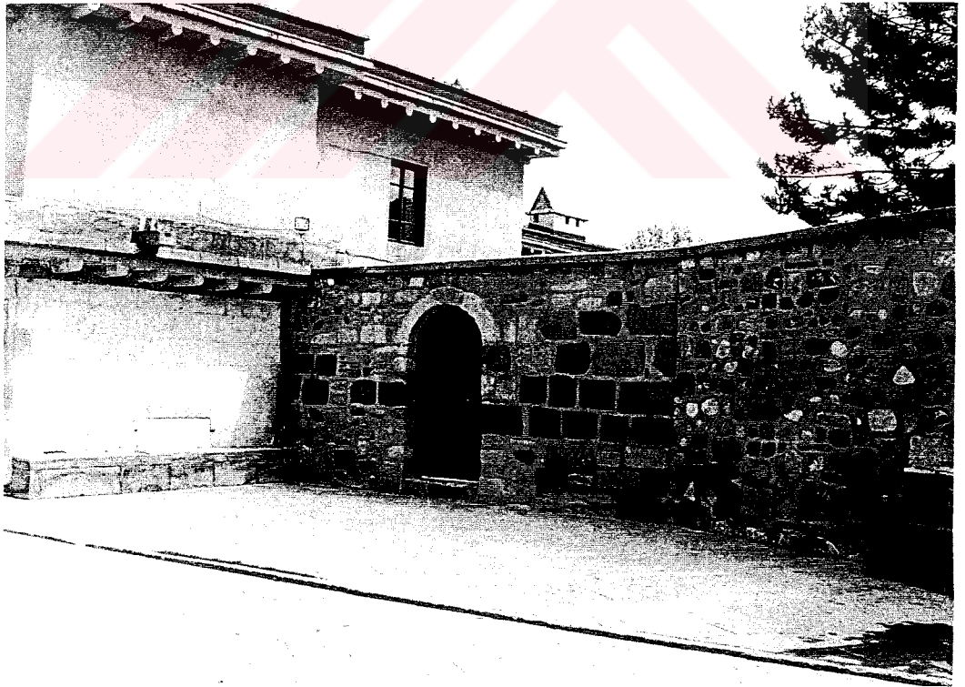
Resim 17. Eski Ekmek Evi'nin Girişini Oluşturan Duvar.
