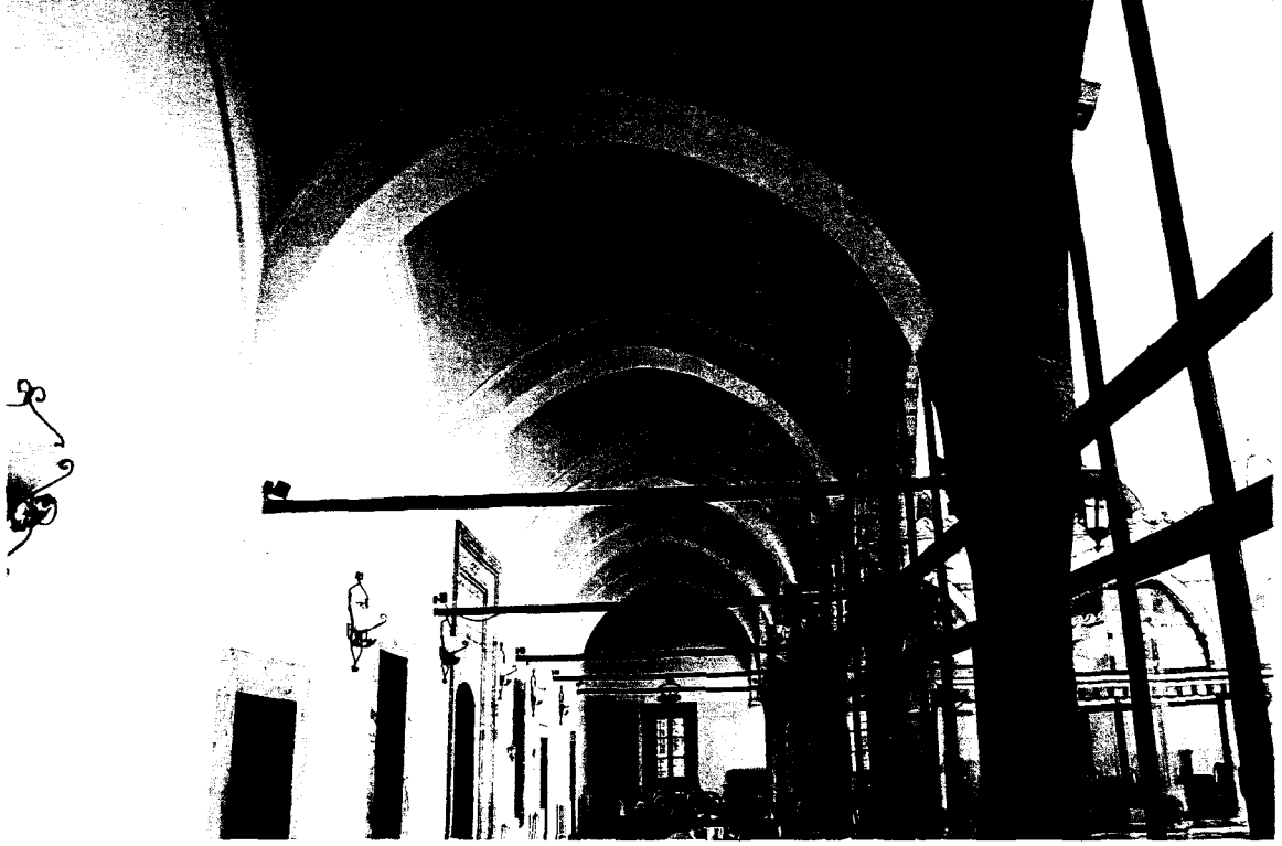
130. Şehzade Mehmet Medresesi avlu revakı.
