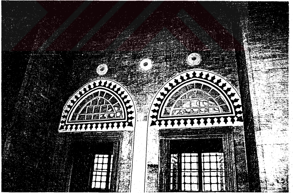
67. Şehzade Mehmet Camii onarım sonrası pencere alınlıklarının etrafındaki kalemîşi bezemeleri.
