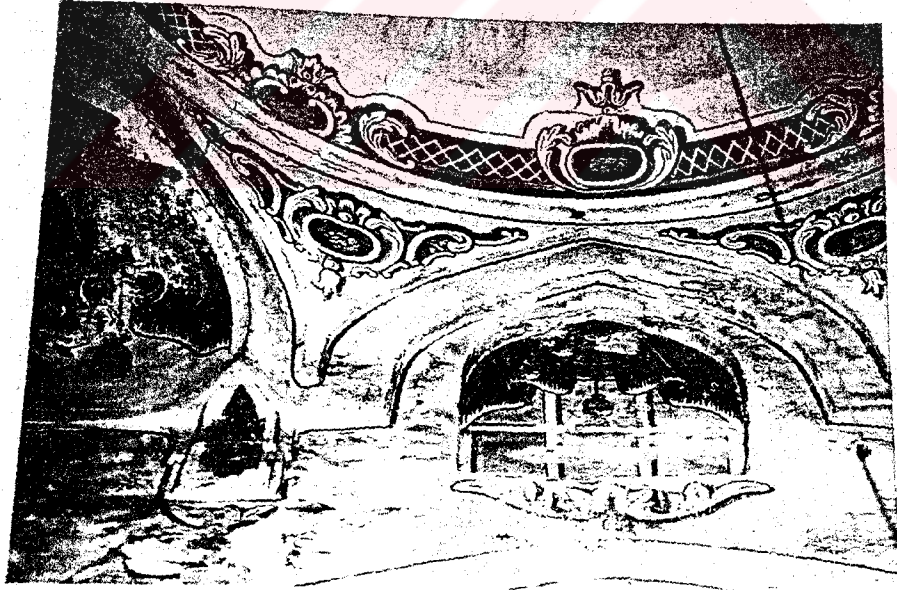
50. Şehzade Mehmet Camii köşe kubbe onarım öncesi kalemîşi bezemesi (İstanbul I Numaralı Kültür ve Tabiat Varlıklarını Koruma Kurulu Arşivi'ndeki, C-87 numaralı Şehzade Mehmet Camii Dosyası'ndan).
