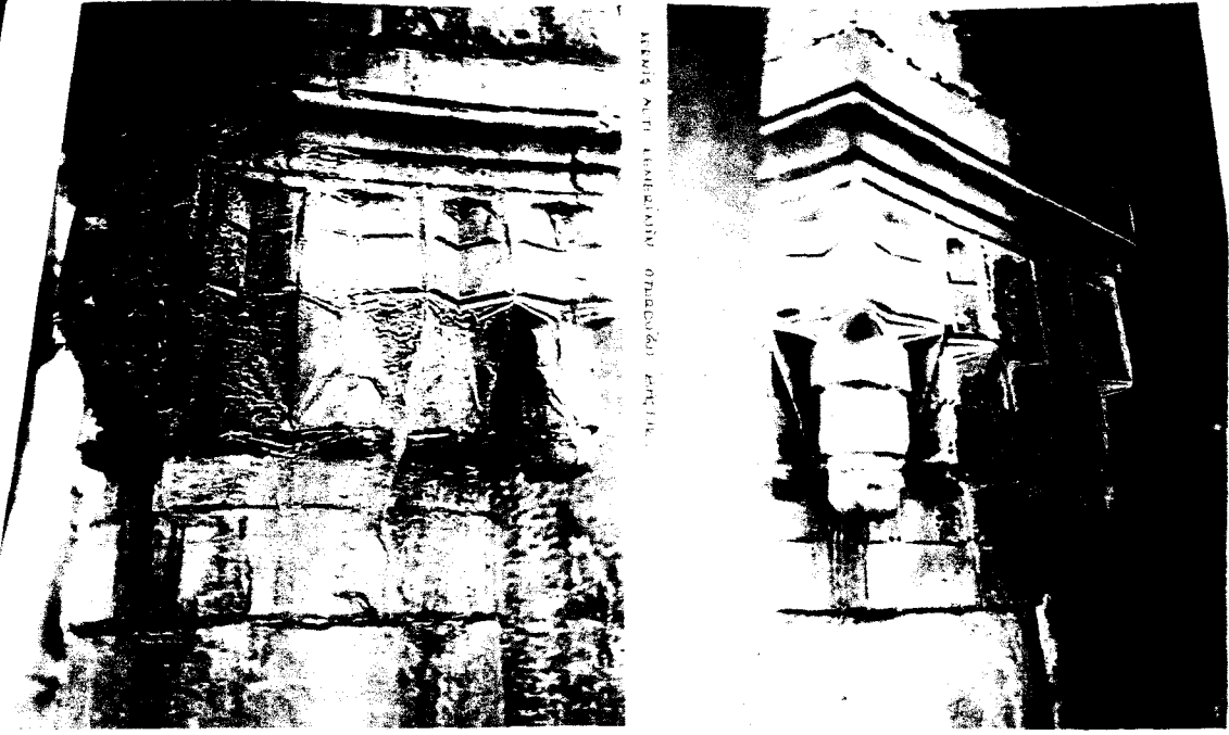
154. Şehzade Mehmet Camii sütun başlığındaki imitasyon mermer kullanımı ( İstanbul Vakıflar Bölge Müdürlüğü Arşivi'ndeki, Şehzade Mehmet Camii'nin onarım öncesi çekilen fotoğraflarının bulunduğu dosyadan).
