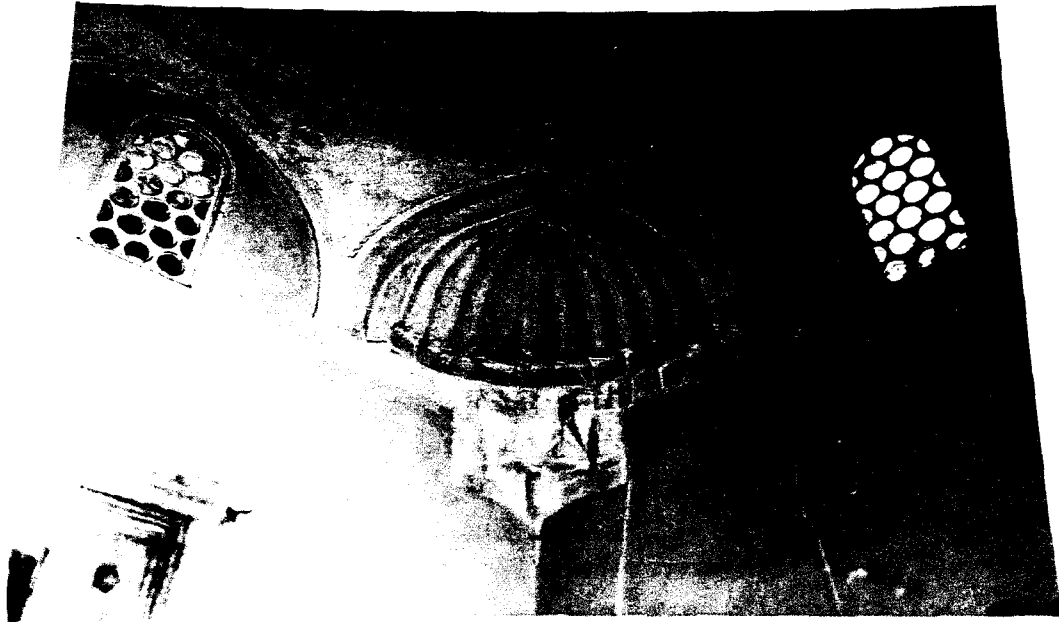
131. Şehzade Mehmet Medresesi derşane kubbeye geçiş ögesi tromp.
