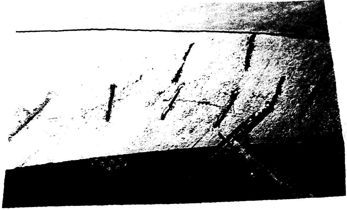
146. Şehzade Mehmet Camii merkezi kubbe kemerindeki çatlakların onarım sonrası durumu ( İstanbul Vakıflar Bölge Müdürlüğü Arşivi'ndeki, Şehzade Mehmet Camii'nin onarım öncesi çekilen fotoğraflarının bulunduğu dosyadan).
