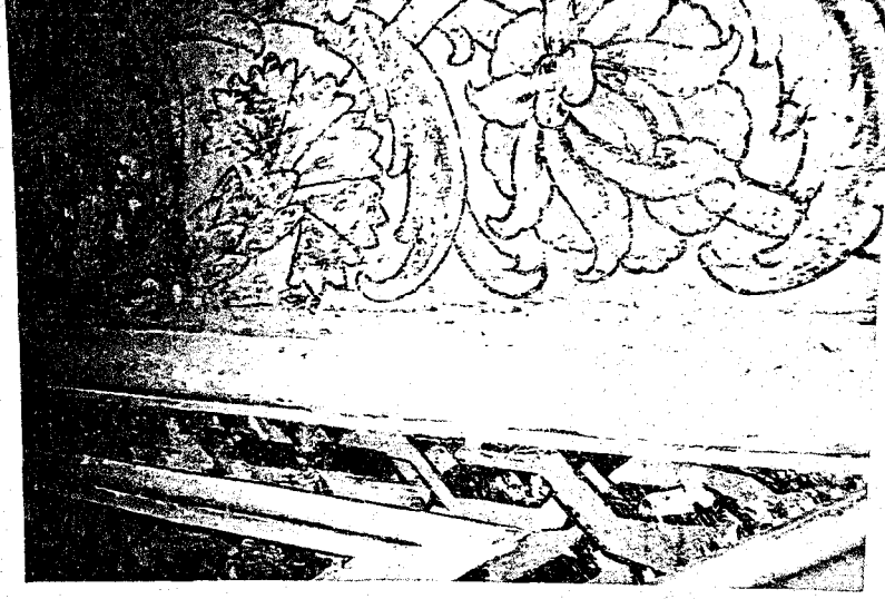
44. Şehzade Mehmet Camii, pandantif çevre bordürü raspa sonrası görünüşü (İstanbul I Numaralı Kültür ve Tabiat Varlıklarını Koruma Kurulu Arşivi'ndeki, C-87 numaralı Şehzade Mehmet Camii Dosyası'ndan).
