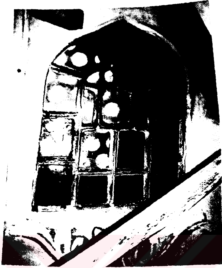
160. Şehzade Mehmet Camii onarım öncesi alçı içlik pencerelerin durumu (İstanbul Vakıflar Bölge Müdürlüğü Arşivi'ndeki, Şehzade Mehmet Camii'nin onarım öncesi çekilen fotoğraflarının bulunduğu dosyadan).
