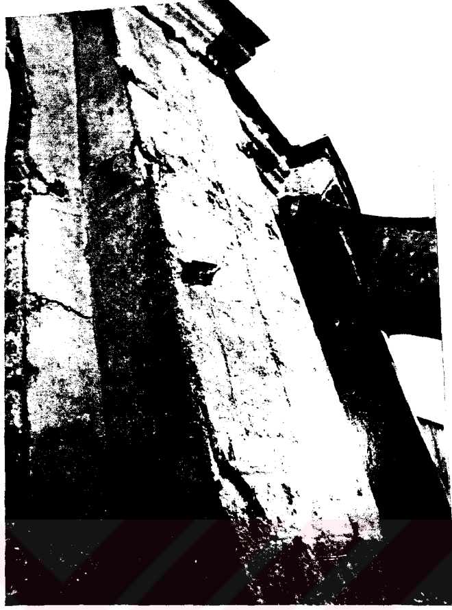
144. Şehzade Mehmet Camii merkezi kubbe kasağındaki kurşunlar söküldükten sonra çamur sıvanın durumu ( İstanbul Vakıflar Bölge Müdürlüğü Arşivi'ndeki, Şehzade Mehmet Camii'nin onarım öncesi çekilen fotoğraflarının bulunduğu dosyadan).
