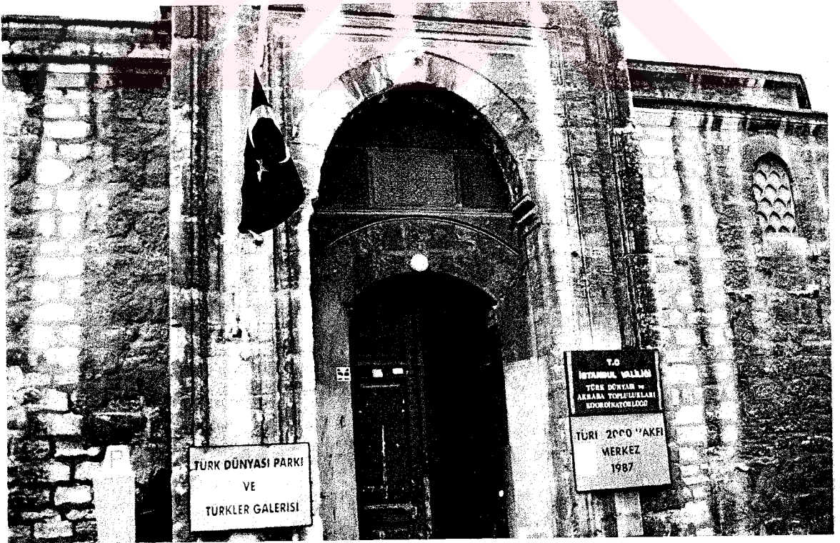
(Resim 43) İstanbul Rüstem Paşa Medresesi, Doğu Dış Cephe ve Giriş
