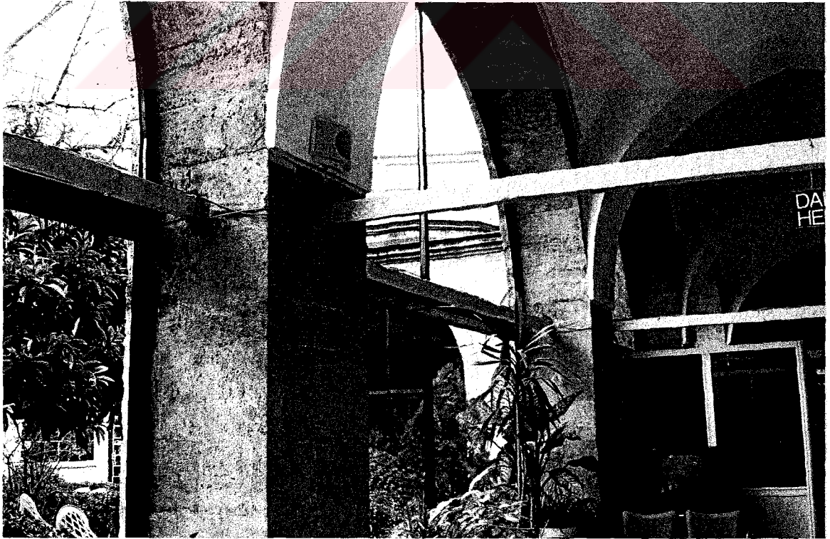
(Resim 41) İstanbul Yavuz Sultan Medresesi, Kuzey Revaktan Görünüş
