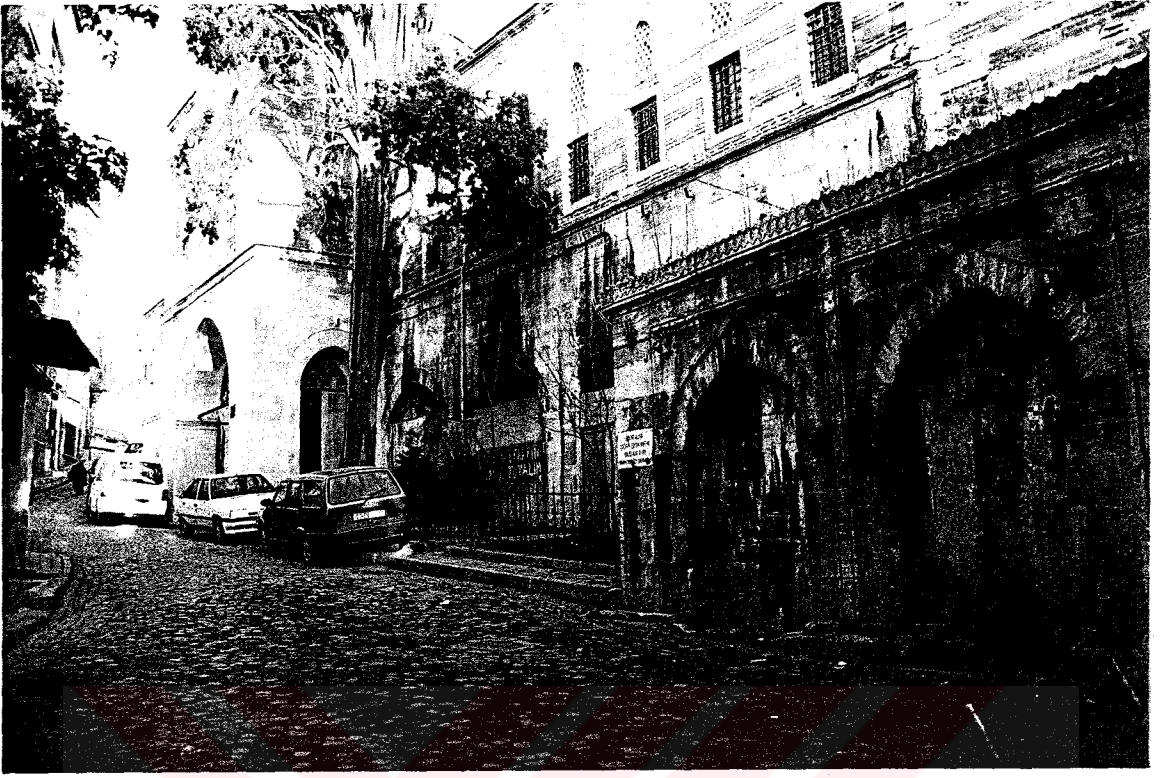
(Resim 125) Kadırga Sokollu Mehmed Paşa Medresesi, Kuzey Dış Cepheden Görünüş
