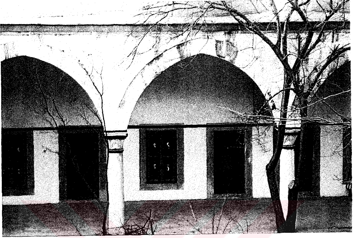
(Resim 154) Üsküdar Atik Valide Sultan Medresesi, Avlu Revak Cephesi ve Hücreler
