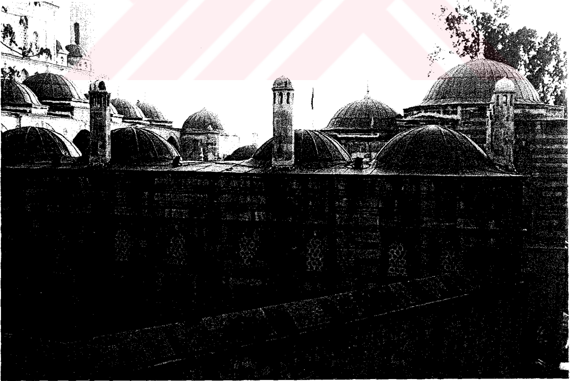
(Resim 128) Kadirga Sokollu Mehmed Paşa Medresesi, Doğu Dış Cephe Düzeni
