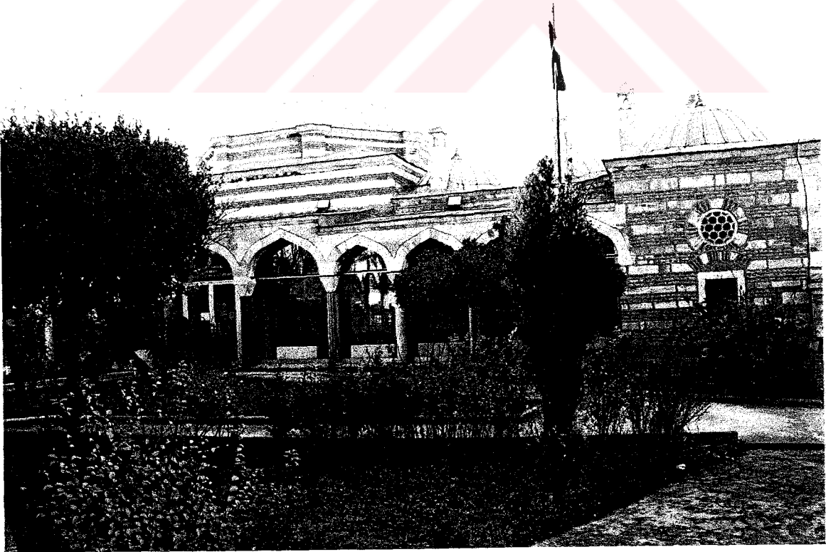
(Resim 130) Üsküdar Şemsi Ahmed Paşa Medresesi, Avlu'dan Dershane Görünüşü
