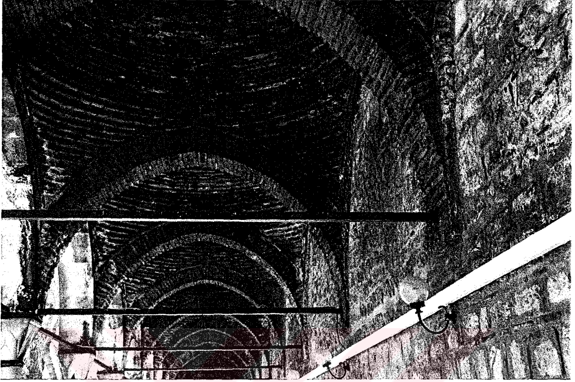
(Resim110)Edirnekapı Mihrimah Sultan Medresesi, Tuğla Revak Örgüsü
