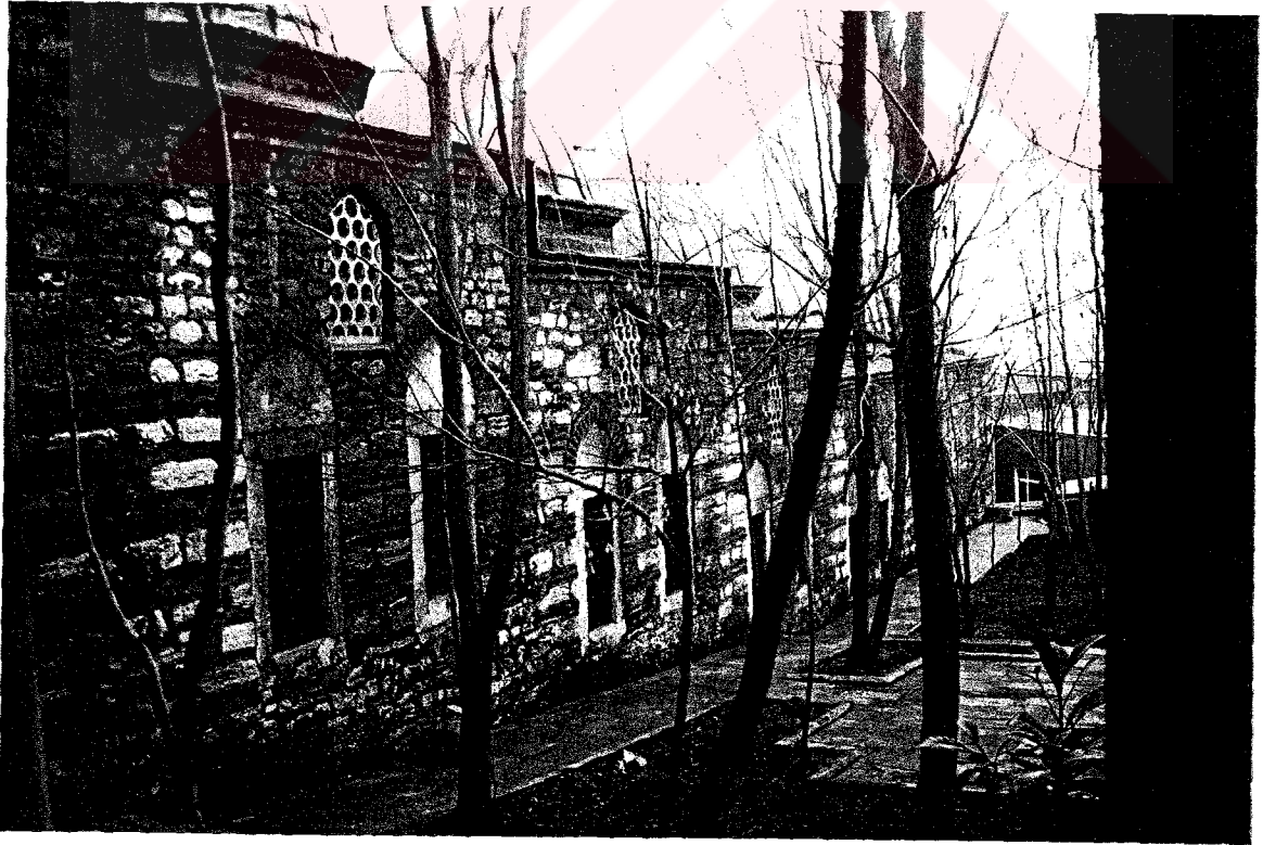
(Resim 93) Süleymaniye Sani Medresesi, Güney Dış Cephe
