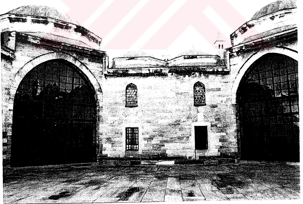
(Resim 51) Haseki Hürrem Sultan Darüşşifası Avlu Cephe Düzeni ve Pencereleler
