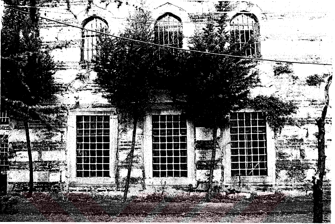
(Resim 166) Tophane Kılıç Ali Paşa Medresesi, Dershane Cephe Düzeni
