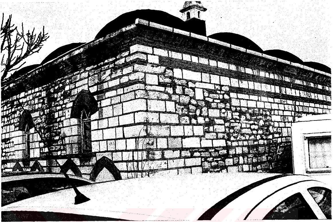
(Resim 120) Eyüp Sokollu Mehmed Paşa Medresesi, Güneybatı Dış Cephe
