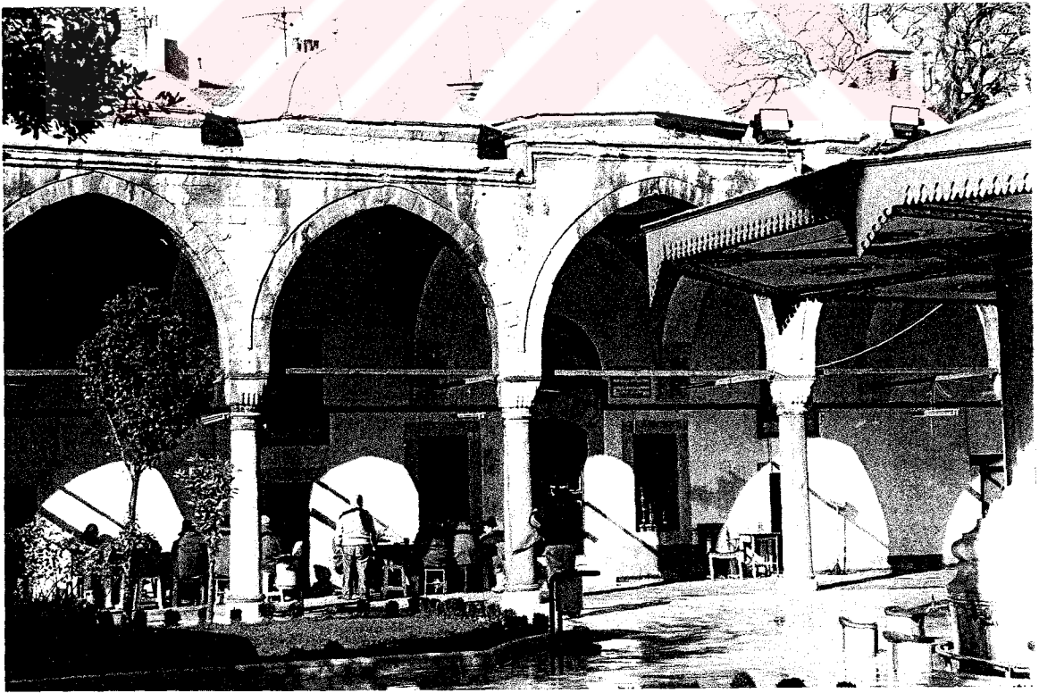
(Resim 102) Topkapı Kara Ahmed Paşa Medresesi, Dershane ve Güney Revaktan Görünüş
