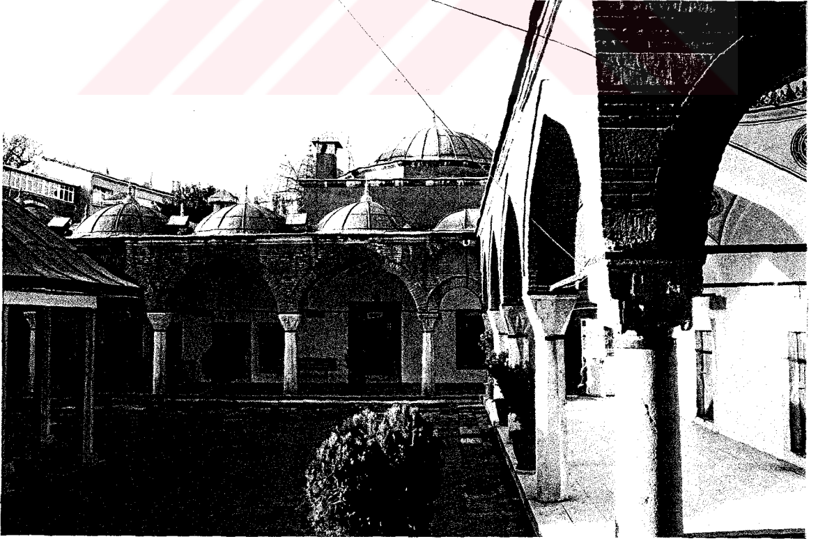
(Resim 140) Eyüp Zal Mahmud Paşa Fevkani Medresesi, Avlu'dan Genel Görünüş
