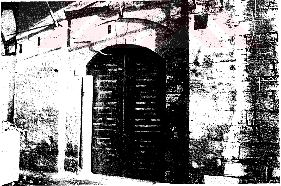
(Resim 73) Süleymaniye Tıp Medresesi, Kuzey Cephesi'nden Görünüş
