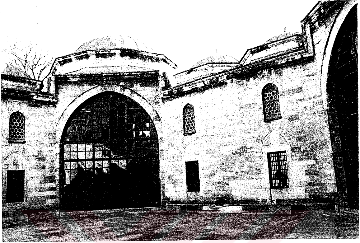
(Resim 48) Haseki Hürrem Sultan Darüşşifası Avlu Cephesinden Görünüş
