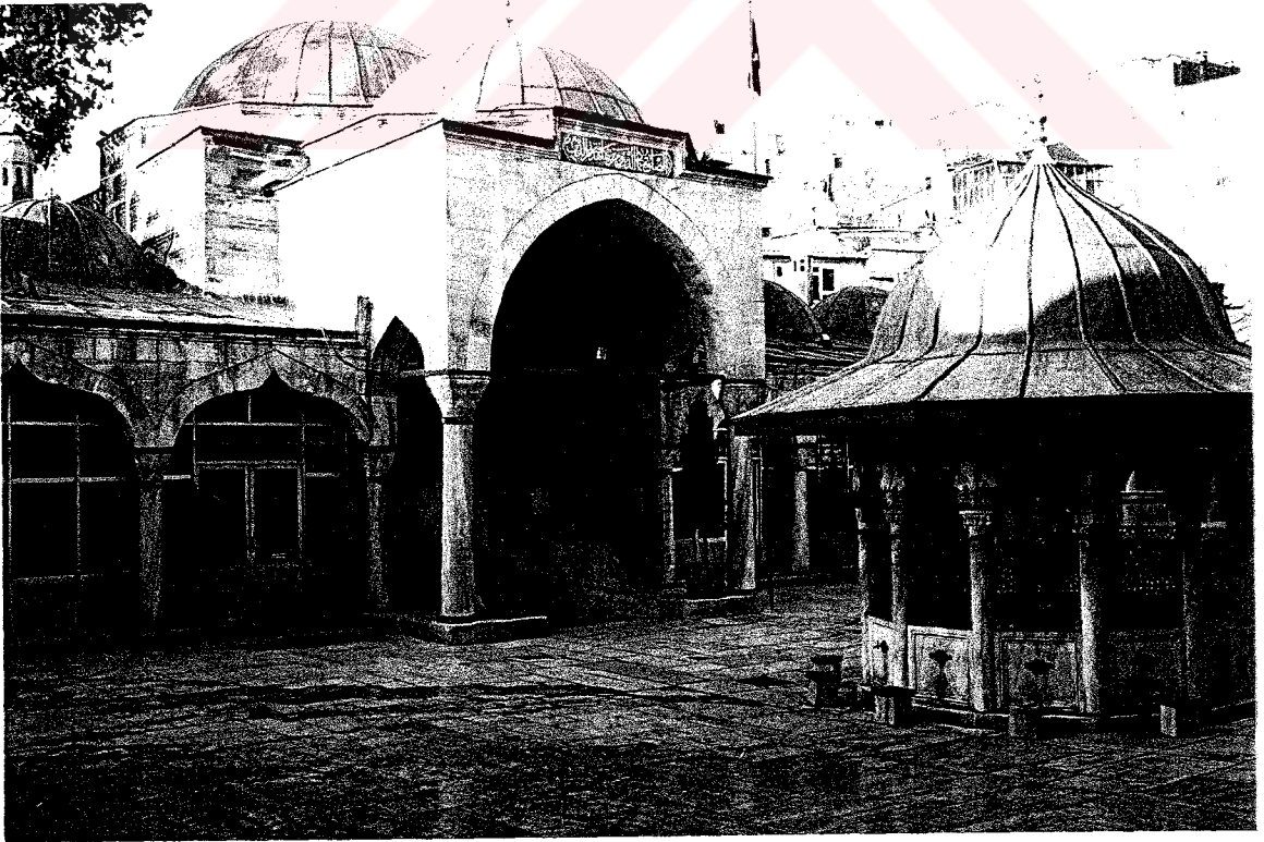
(Resim 126) Kadırga Sokollu Mehmed Paşa Medresesi, Avlu'dan Görünüş
