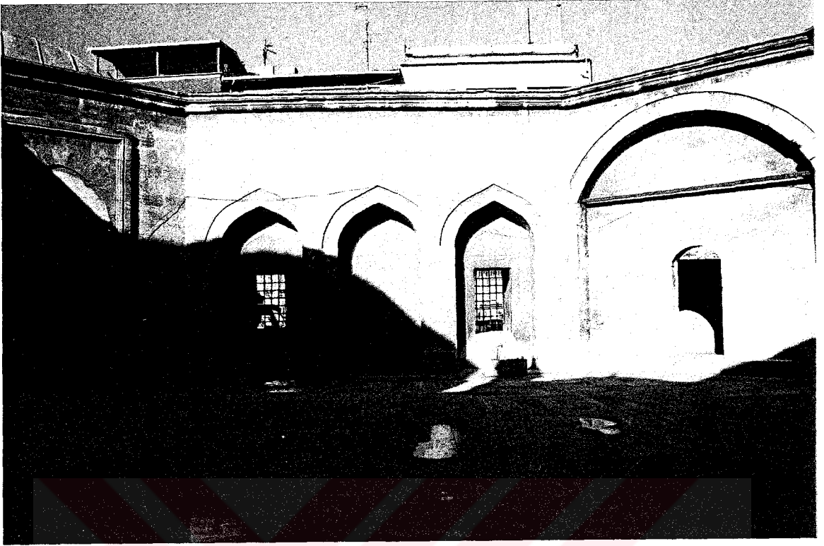
(Resim 50) Haseki Hürrem Sultan Darüşşifası Avlu Cephesi ve Kemer Düzeni
