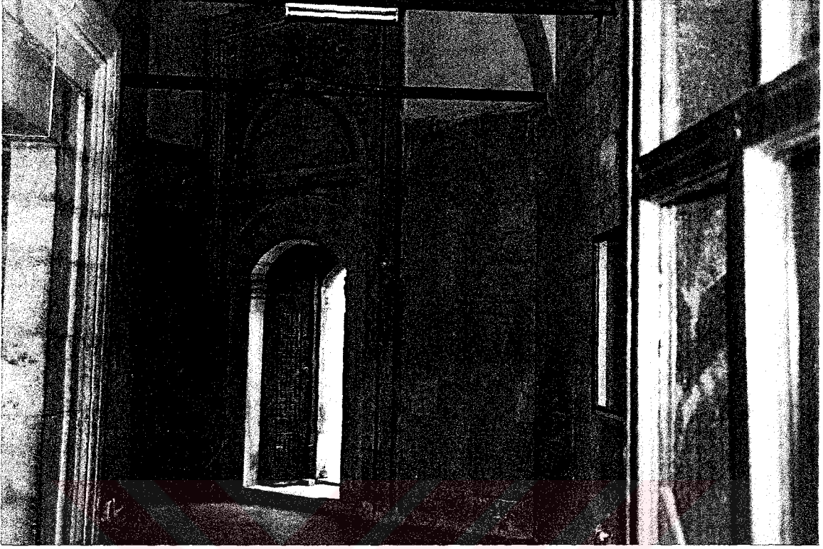
(Resim 54) Haseki Hürrem Sultan Darüşşifası Giriş İç Kısım ve Cephe Düzeni
