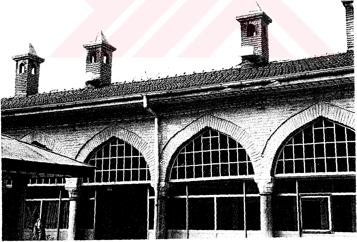
(Resim 81) Beşiktaş Sinan Paşa Medresesi; Kuzey Revak Cephesi, Örtü ve Bacalar
