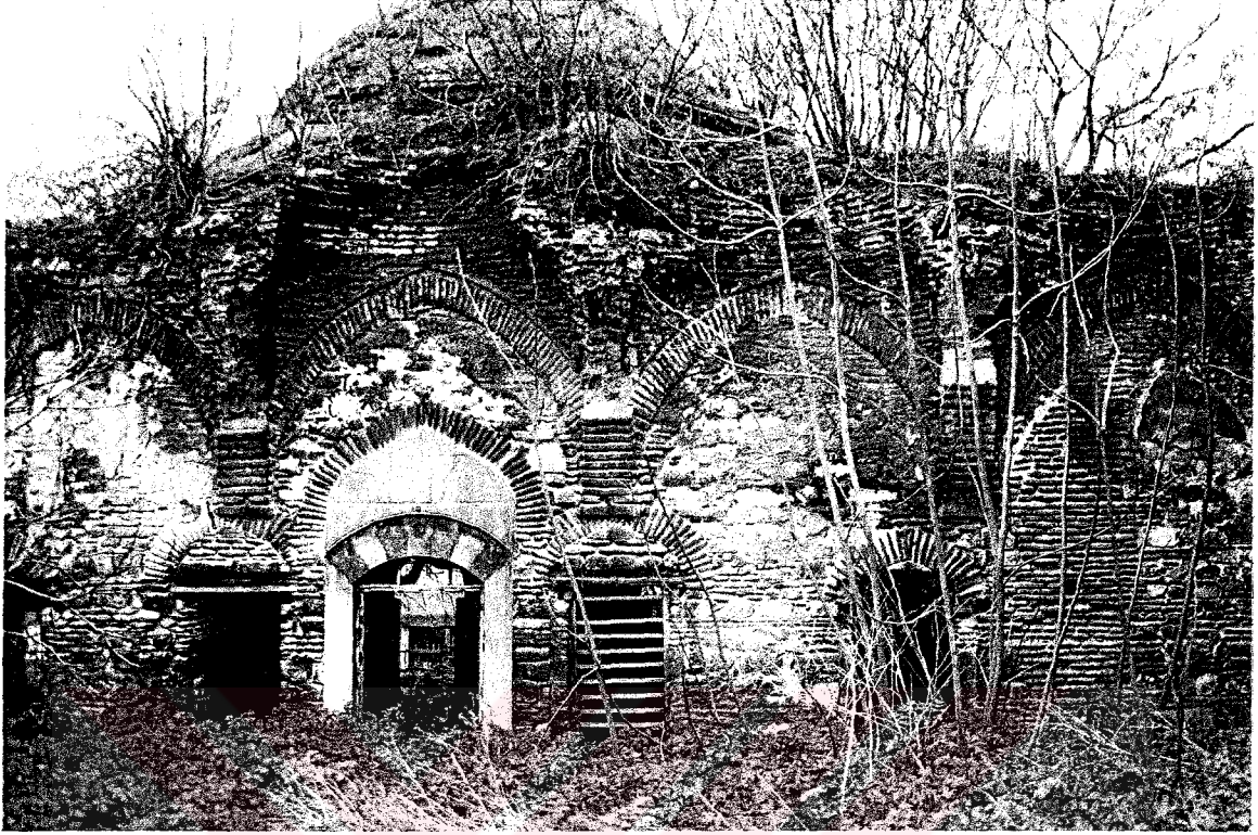
(Resim 97) Esekapı Hadım İbrahim Paşa Medresesi, Avlu'dan Dershane Duvar Örgüsü
