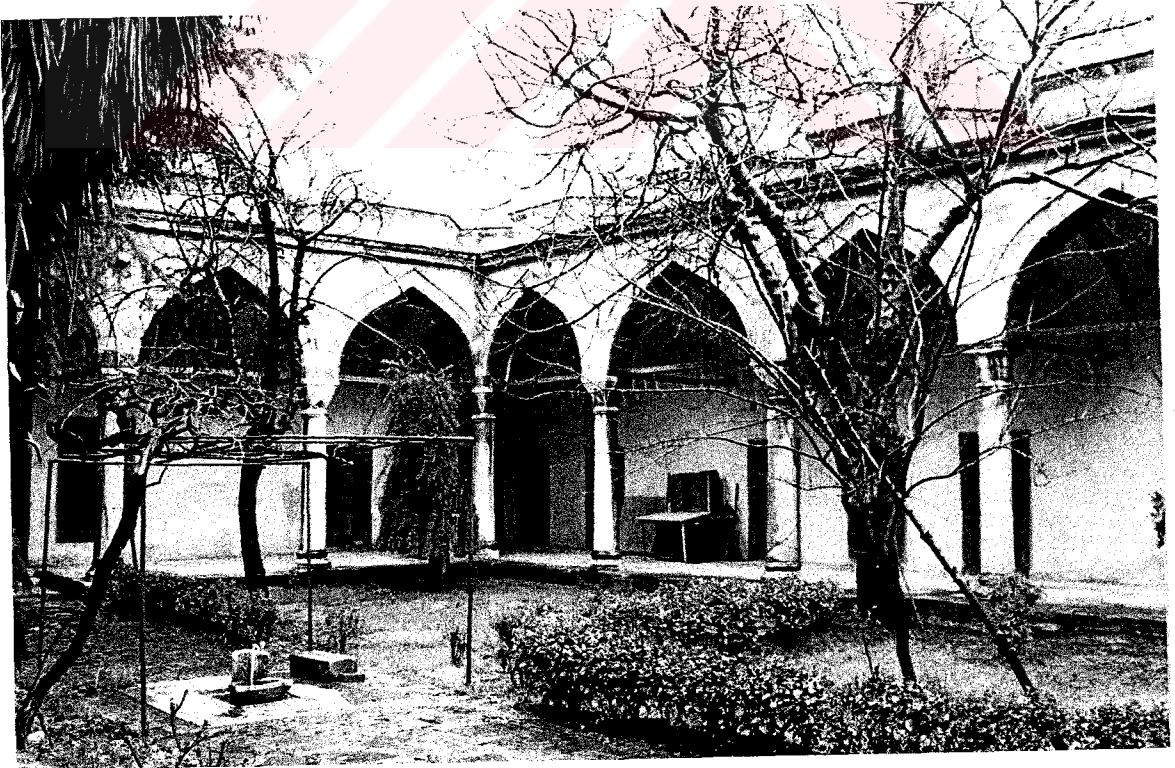
(Resim 12) Haseki Hürrem Sultan Medresesi, Doğu Revak Cephesi
