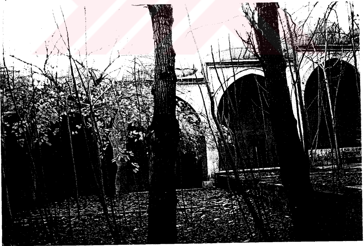
(Resim 91) Süleymaniye Sani Medresesi, Avlu'dan Batı Revak Cephesi
